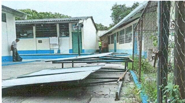
Foto1: CAMBIO DE ESTRUCTURA METÁLICA
