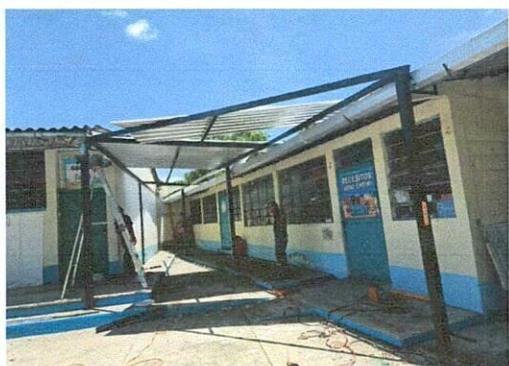
Foto 3: INSTALACIÓN DE NUEVA ESTRUCTURA METÁLICA
