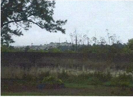
Foto 1: muro perimetral culminado
