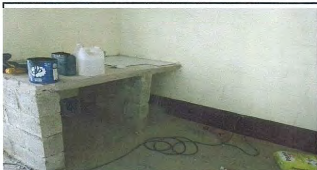
Foto 1: IMÁGENES DE LA ELABORACIÓN DE LA MESA DE CONCRETO
