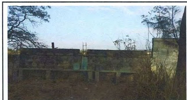
Foto 5: PROCESO DE LEVANTAR MURO PERIMETRAL
