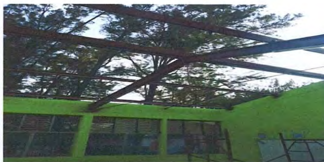
Foto 6: CAMBIO DE DURALITA POR LÁMINA
