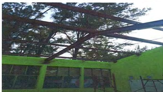
Foto 1: IMÁGENES DEL CAMBIO DE TECHADO
