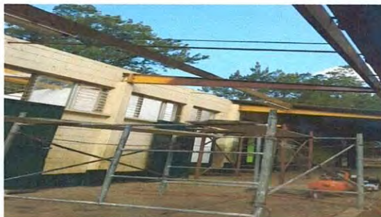
Foto 2: IMAGEN DE CAMBIO DE TECHADO DE CORREDORES
