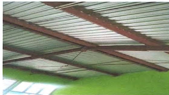
Foto 6: CAMBIO DE DURALITA POR LÁMINA
