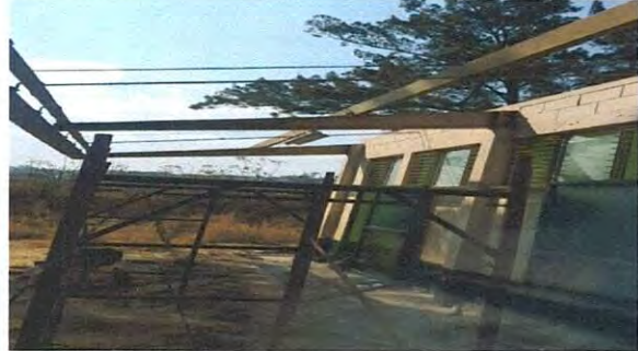
Foto 2: IMAGEN DE CAMBIO DE TECHADO DE CORREDORES
