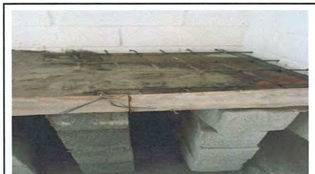
Foto 4: PROCESO DE ELABORACIÓN DE MESA DE CONCRETO DE LA COCINA
