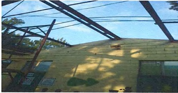
Foto 1: IMÁGENES DEL CAMBIO DE TECHADO
