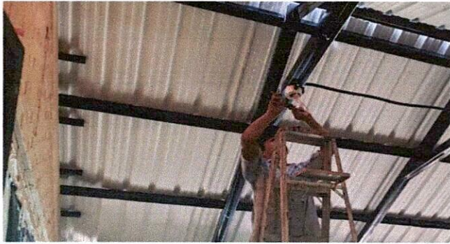
Foto1: Colocación de flexi tubo en alambrado eléctrico de las aulas beneficiadas
