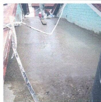
Foto 6: Uso de los materiales para fundición de mezlón
