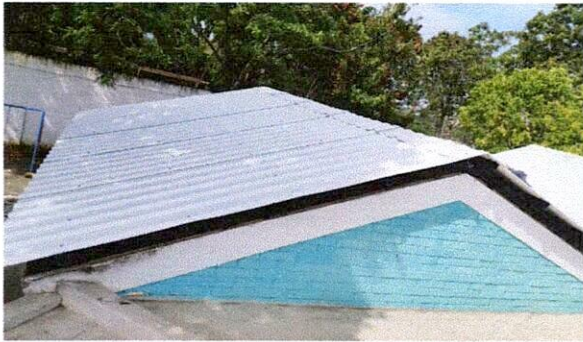
Foto 3: Trabajo terminado de aula
