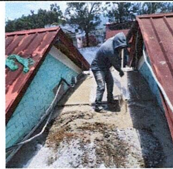
Foto 6: Materiales para retirar y fundir mezcón en terraza
