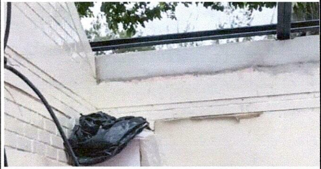
Foto 4: Colocación de una hilada de block para cerrar espacio de desmontaje de tablas
