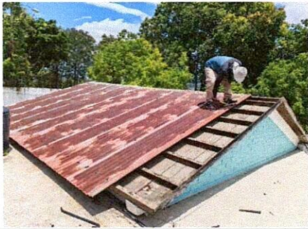
Foto1: Desmontaje de láminas
