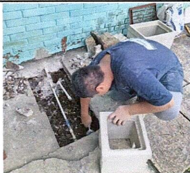
Foto 5: Colocación de caja de concreto para contador y llave
