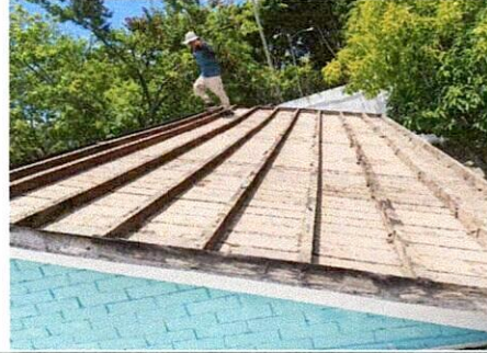
Foto 2: Desmontaje de estructuras de madera.
