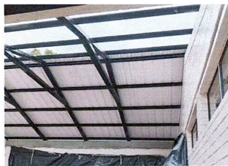
Foto 6: Instalación de láminas termoacústicas triple capa
