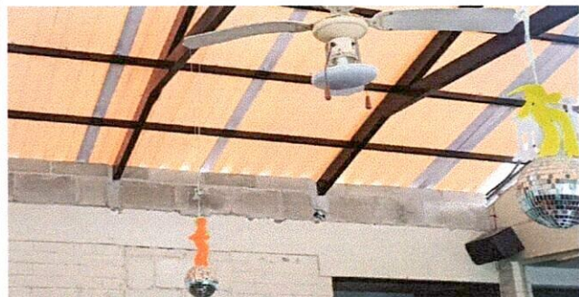
Foto1: Colocación de block para sellar espacio por cambio de estructura
