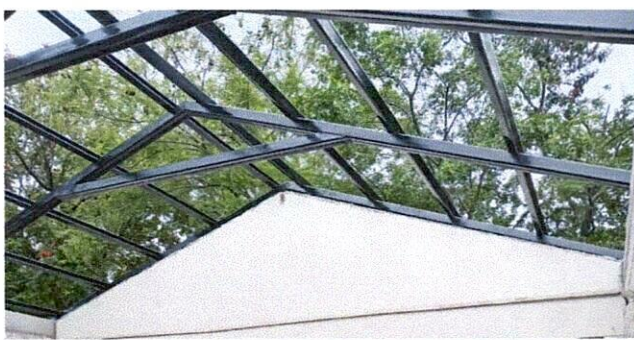
Foto 5: Instalación de estructura
