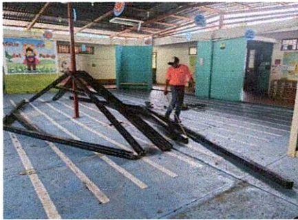
Foto 3: Fabricación de estructuras metálicas
