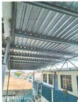
Foto 1: Finalización de trabajos de extensión de techo en patio.
