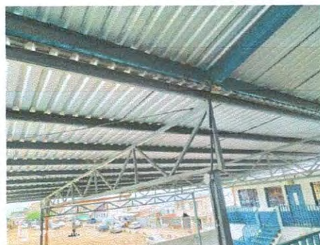
Foto 4: Canal reparado, ya no permite la filtración de agua pluvial.
