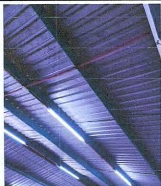
Foto 3: Trabajos finalizados de sistema eléctrico en aulas 2o. Nivel
