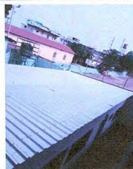
Foto 2: Trabajos finalizados de sustitución de lámina troquelada por lámina termoacústica en Segundo Básico B y sala de maestros
