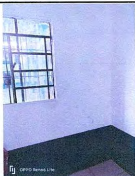
Foto 3: Trabajos finalizados de pintura en aulas
