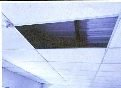
Foto 4: Vista interna de sustitución de lámina troquelada por lámina termoacústica en Segundo Básico B.
