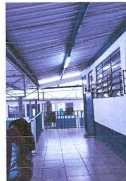
Foto 2: Trabajos finalizados de sistema eléctrico en aulas 2o. Nivel
