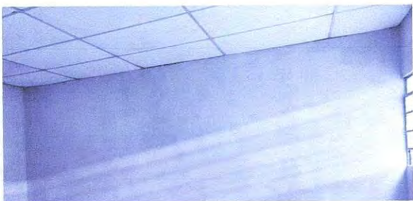
Foto 3: Finalización de trabajos de repello y cernido en paredes
