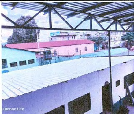
Foto1: Trabajos finalizados de sustitución de lámina troquelada por lámina termoacústica en Segundo Básico B y sala de maestros
