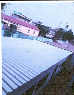
Foto 3 Trabajos finalizados de sustitución de lámina troquelada por lámina termoacústica en Segundo Básico B y sala de maestros
