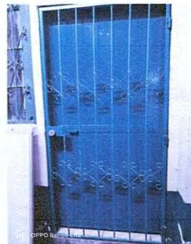
Foto 2: Trabajos de pintura en puerta
