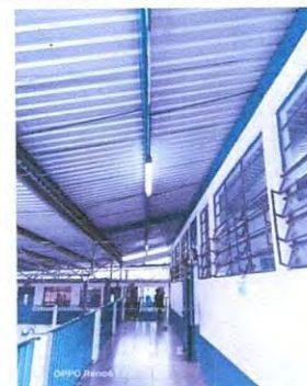
Foto 6: Trabajos finalizados de sistema eléctrico en aulas 2o. Nivel
