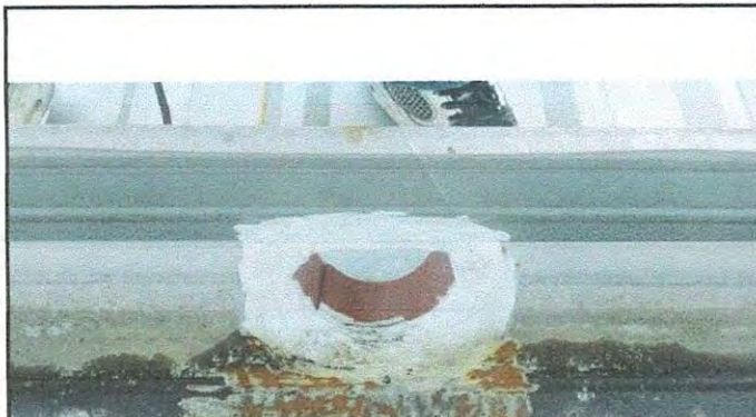
Foto 3: Reparación de tubo de salida de agua pluvial atascado anteriormente con arena volcánica y hollín.
