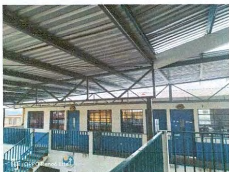
Foto 3: Finalización de trabajos de extensión de techo en patio.
