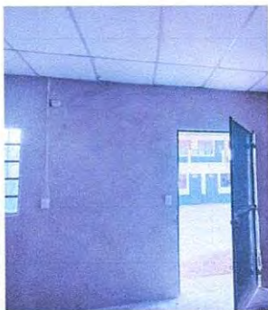
Foto1: Trabajos de repello y cernido finalizados.
