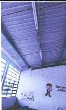
Foto 1: Trabajos finalizados de sistema eléctrico en aulas 2o. Nivel
