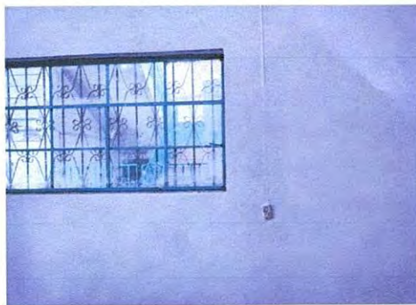
Foto 2: Trabajos de repello y cernido en paredes finalizados.
