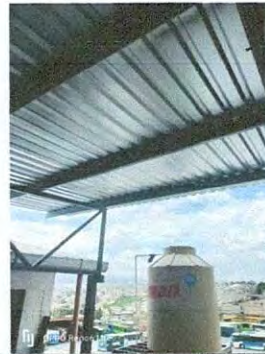
Foto 2: Finalización de trabajos de extensión de techo en patio.
