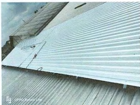
Foto 5: Vista exterior de los trabajos de extensión de techo en patio.
