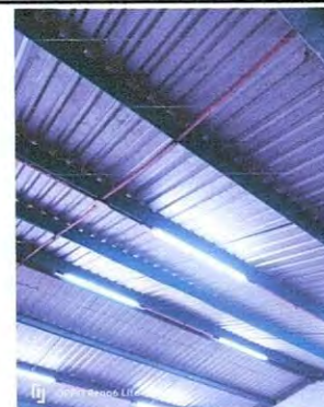
Foto 4: Trabajos finalizados de sistema eléctrico en aulas 2o. Nivel
