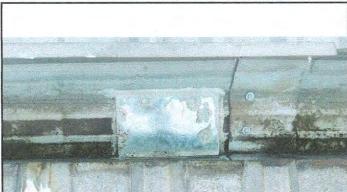
Foto 1: Limpieza de canal y reparación
