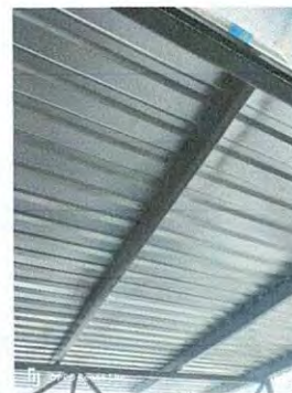
Foto 4: Finalización de trabajos de extensión de techo en patio.
