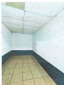
Foto 5: Colocación de piso cerámico en sala de maestros.
