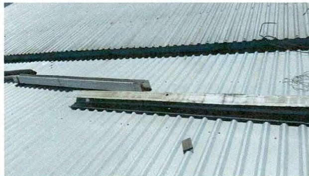
Foto 2: Reparación de canal pluvial.
