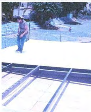
Foto 3: Trabajos de colación de lámina termoacústica.
