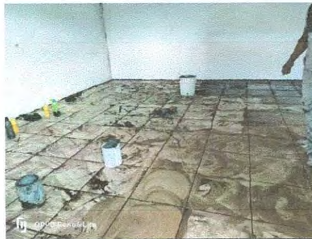
Foto 4: Colocación de piso cerámico.
