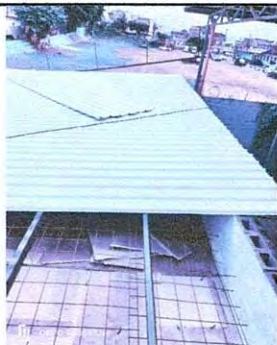
Foto1: Trabajos de colación de lámina termoacústica.
