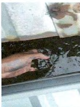
Foto 5: Fase de limpieza de canal.
