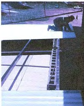
Foto 1: Trabajos de colación de lámina termoacústica.
