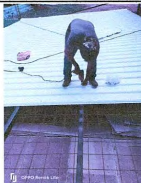
Foto 4: Trabajos de colocación de lámina termoacústica.
