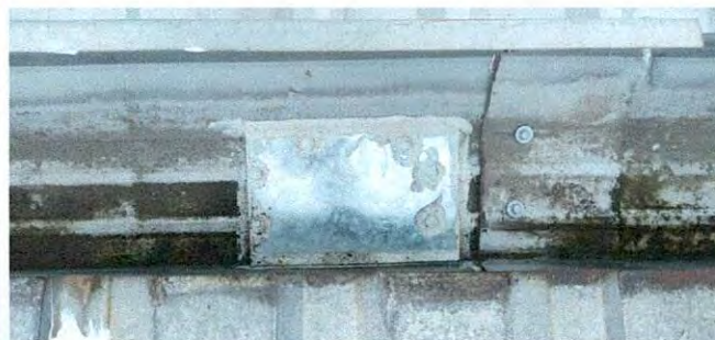
Foto 4: Limpieza y mantenimiento de piezas de canal pluvial.
