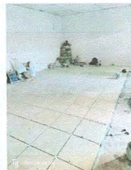
Foto 5: Colocación de piso cerámico.
