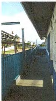
Foto 1: Costanera para estructura de extensión de techo en patio.
