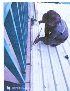
Foto 6: Trabajo de siliconeado en borde de lámina termoacústica.
