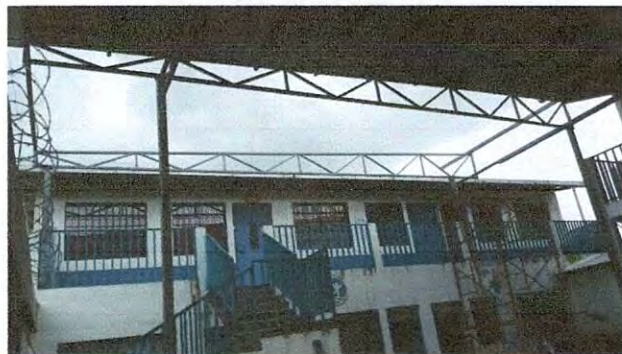
Foto 2: Colocación de estructura de soporte.
