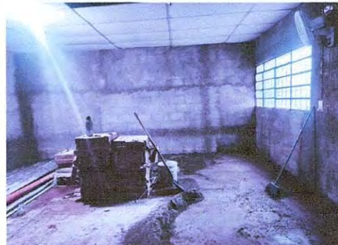
Foto 2: Trabajos de repello y cernido en paredes
