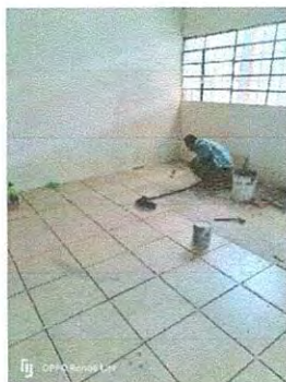
Foto 3: Colocación de piso cerámico.
