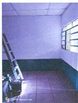
Foto 3: Trabajos de pintura
