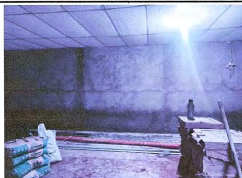
Foto 4: Trabajos de repello y cernido en paredes
