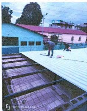
Foto 5: Trabajos de colación de lámina termoacústica.
