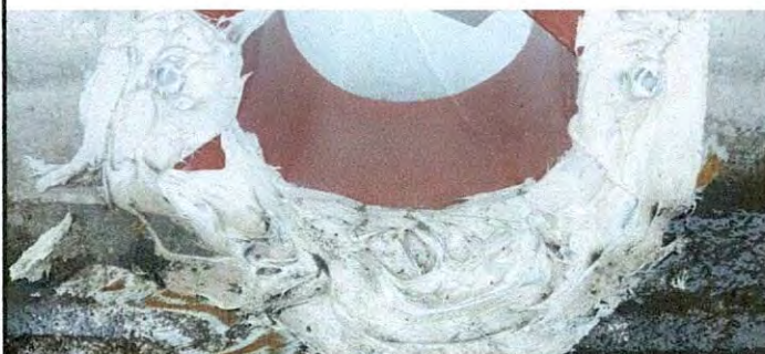
Foto 3: Reparando salida de agua pluvial.
