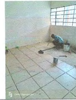
Foto 6: Colocación de piso cerámico.
