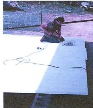
Foto 2: Trabajos de colación de lámina termoacústica.
