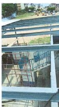
Foto 3: Colocacion de estructura metálica para extensión de techo en patio.
