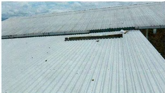
Foto 1: Removiendo canal para su limpieza y reparación.
