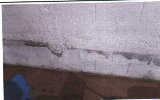
Foto 6: Aplicación de cernido interno de aulas.
