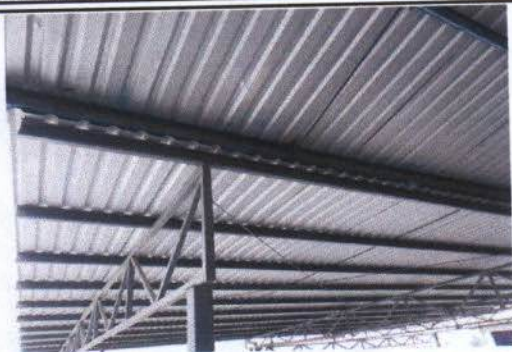
Foto 1: Suministro de instalación de canales.
