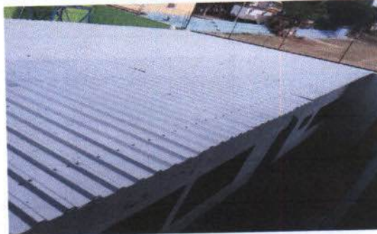
Foto 2: Colocación de lámina termoacústica en aula.
