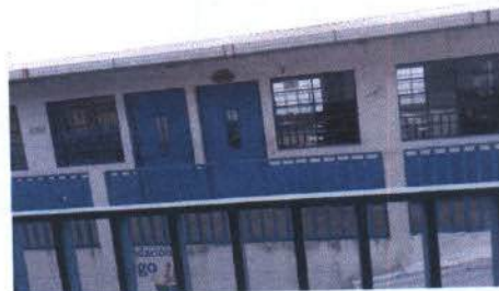
Foto 4: Complemento de techado de patio.
