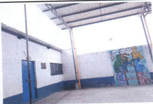
Foto 3: Complemento de muro.
