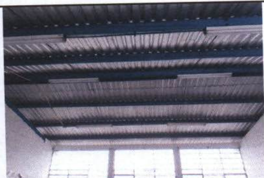
Foto 5: Mejoramiento de sistema eléctrico.
