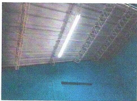
Foto 3: INSTALACIÓN DE LUZ EN BODEGA
