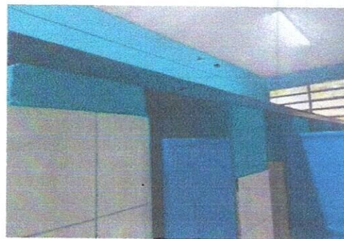
Foto 4: PINTURA DE PUERTA Y PARED EN BAÑOS
