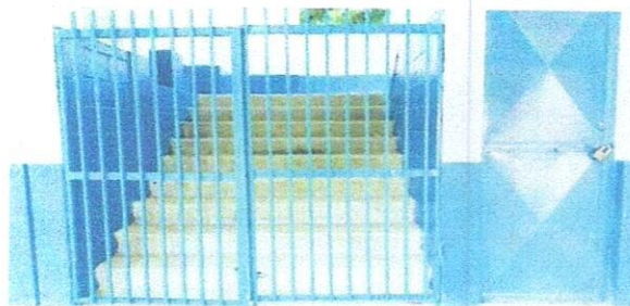
Foto 6: BALCÓN FIJO Y REPARACIÓN DE PORTÓN
