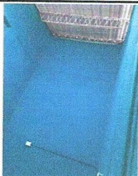
Foto 5: REPELLO Y PINTURA EN BODEGA
