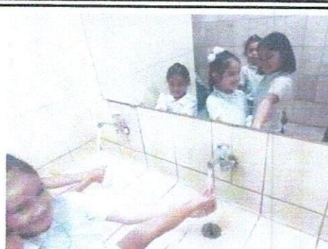
Foto 2: CAMBIO DE LLAVES EN LAVAMANOS
