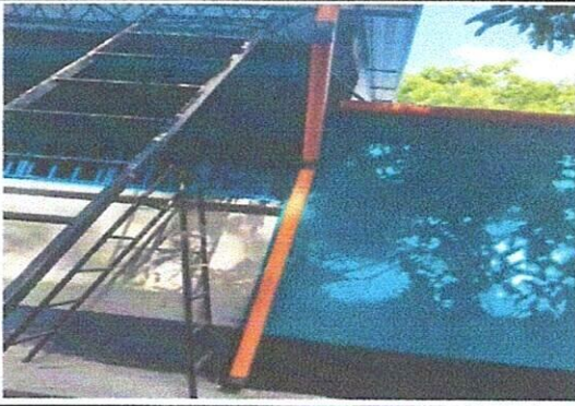
Foto1: CAMBIO DE BAJADA DE AGUA
