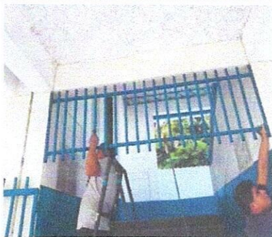
Foto 5: INSTALACIÓN BALCÓN FIJO
