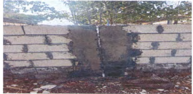
foto 2: Reparacion de muro perimetral
