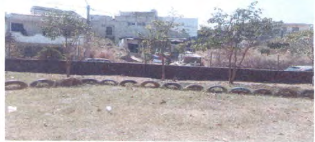
Foto 4: sustitucion de malla galvanizada
