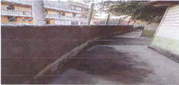
Foto 1: Reparacion de muro perimetral .
