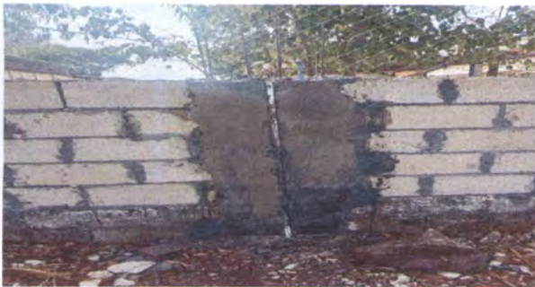
Foto 5 Colocación de columnas de soporte para muro perimetral.
