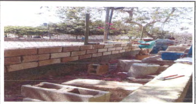
Foto 4: sustitucion de malla galvanizada
