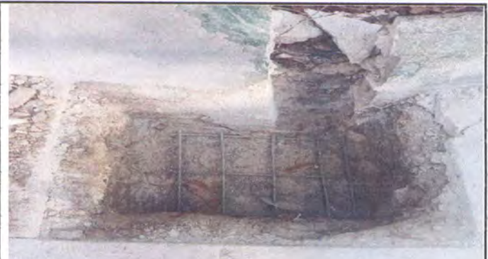
foto 2: Reparacion de muro perimetral
