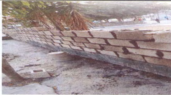
Foto 1: Reparacion de muro perimetral .
