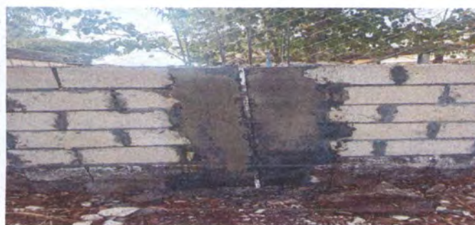
Foto 5 Colocación de columnas de soporte para muro perimetral.
