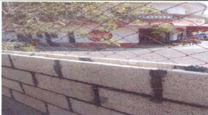
Foto 3: sustitucion de malla galvanizada
