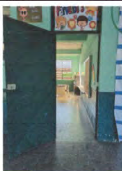
Foto 6: Realización de puerta de rejilla
