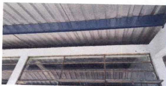
Foto 4: ESTRUCTURA DE TECHO
