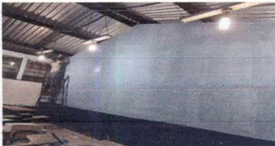
Foto 14: REPARACION DE RPELLO Y CERNIDO DE PARED
