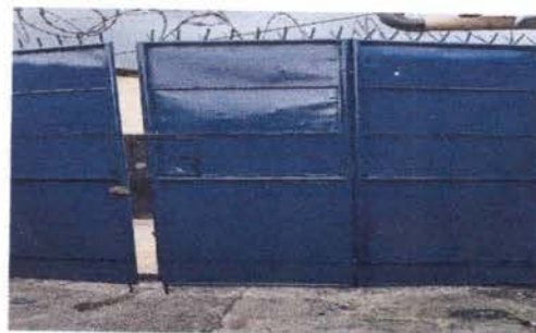
Foto 11: MANTENIMIENTO DE PORTON
