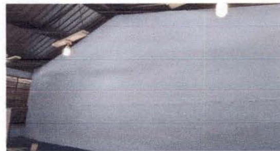
Foto 15: REPARACION DE RPELLO Y CERNIDO DE PARED
