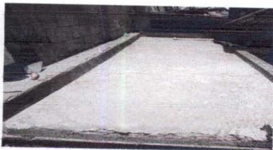
Foto 4: IMPERMEABILIZACION DE LOZA
