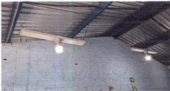
Foto 12: REPARACION DE SISTEMA ELECTRICO
