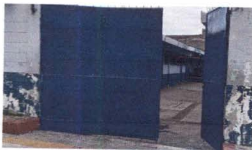
Foto 10: MANTENIMIENTO DE PORTON
