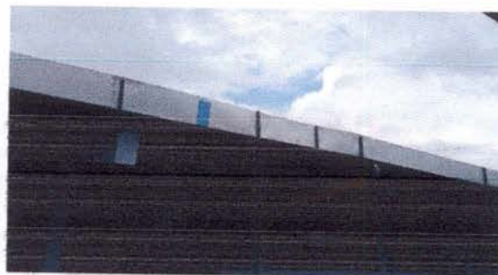
Foto 7: CANALES Y BAJADAS DE AGUA PLUVIAL
