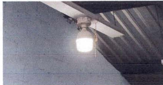
Foto 13: REPARACION DE SISTEMA ELECTRICO
