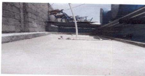
Foto 5: IMPERMEABILIZACION DE LOZA
