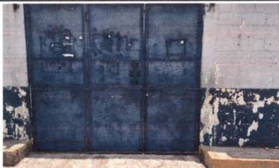
Foto 11: MANTENIMIENTO DE PORTONES
