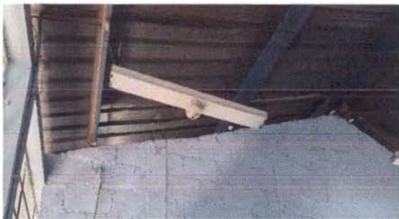
Foto 13: REPARACION DE SISTEMA ELECTRICO
