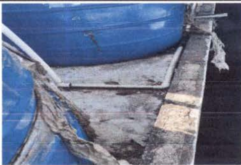
Foto 5: IMPERMEABILIZACION DE LOSA
