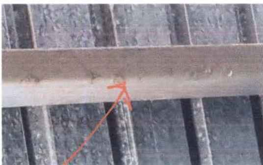
Foto 3: ESTRUCTURA DE TECHO
