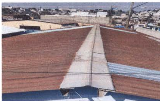
Foto 2: CUBIERTA DE LAMINA
