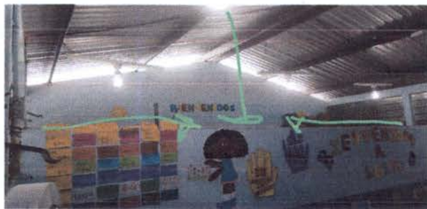
Foto 15: REPARACION DE REPELO Y CERNIDO DE PARED
