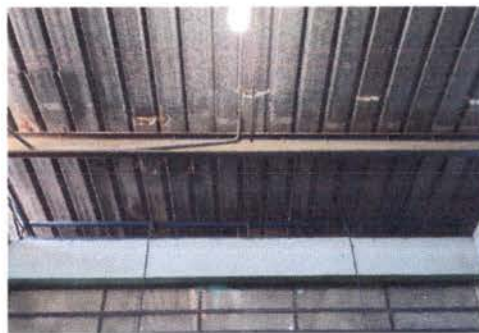
Foto 4: ESTRUCTURA DE TECHO
