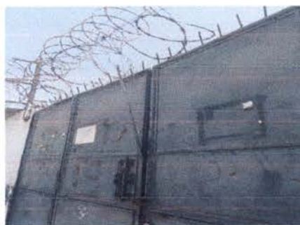
Foto 12: MANTENIMIENTO DE PORTONES
