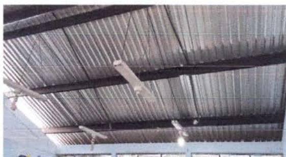
Foto 14: REPARACION DE SISTEMA ELECTRICO
