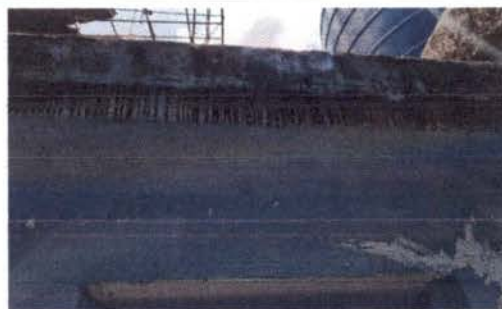
Foto 6: IMPERMEABILIZACION DE LOZA
