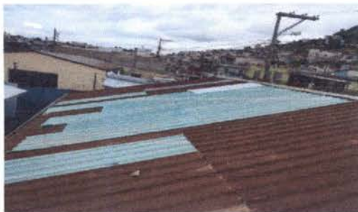
Foto 1: CUBIERTA DE LAMINA
