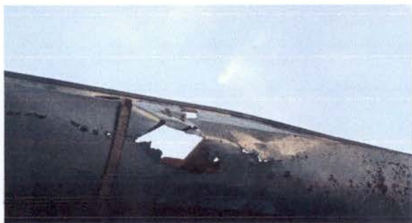
Foto 7: CANALES Y BAJADAS DE AGUA PLUVIAL
