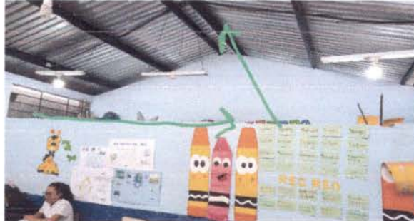
Foto 16: REPARACION DE REPELO Y CERNIDO DE PARED
