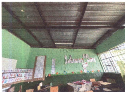
REPARACIÓN DE PARED
