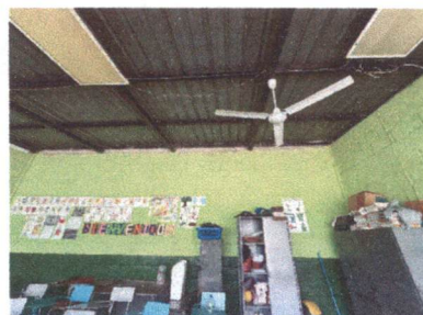
REPARACIÓN DE PARED
