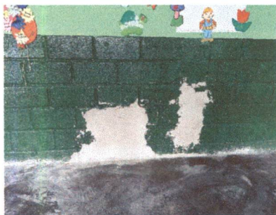
REPARACIÓN DE PARED
