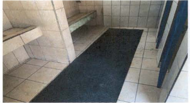
Foto 2: PISO, SUSTITUCION DE PISO
