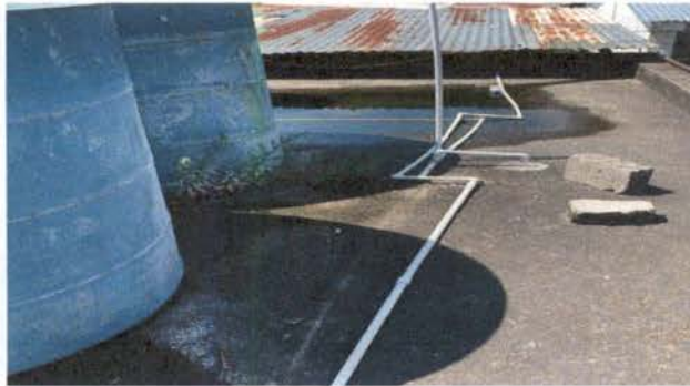
Foto 3: IMPERMEABILIZACION DE LOSA, REPARACION DE PAÑUELOS
