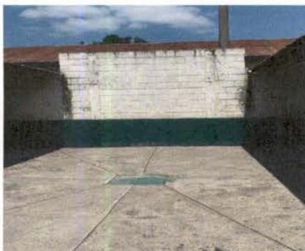
Foto 7: MURO PERIMETRAL, DONDE SE COLOCARA PORTON
