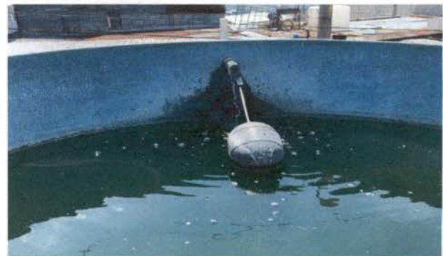
REPARACION Y MATENIMIENTO DE CISTERNAS/ DEPOSITOS DE AGUA, SUSTITUCION DE ACCESORIOS DEPOSITOS DE AGUA
