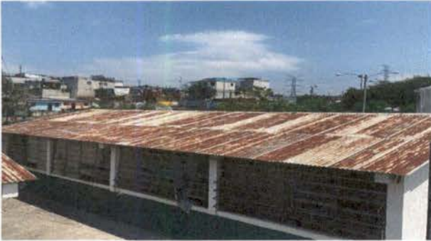
Foto1: CUBIERTA DE LAMINA SUSTITUCION DE LAMINA
