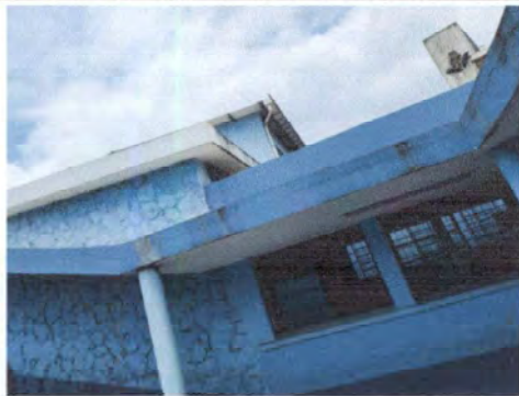
Foto 7: 9.PINTURA DE MUROS EXTERIORES E INTERIORES: Aplicación de pintura en muros exteriores e interiores en dos tonalidades
