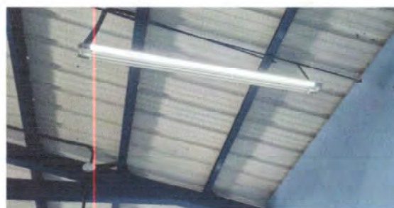
Foto 24: Cambio de lámpara en aula No. 1 módulo 1
