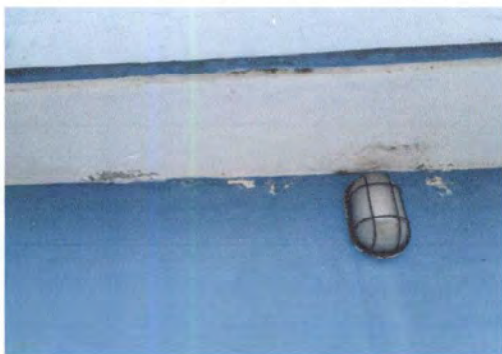
Foto 33: Reparación de filtración de agua en cenefa en el frente de las direcciones
