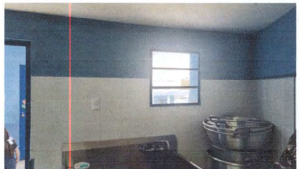
Foto 2: 5 VENTANAS: Desmontaje de ventana de la cocina, ampliación de vano de ventana, instalación de ventana corrediza de metal con medidas 1.30*0.70mts
