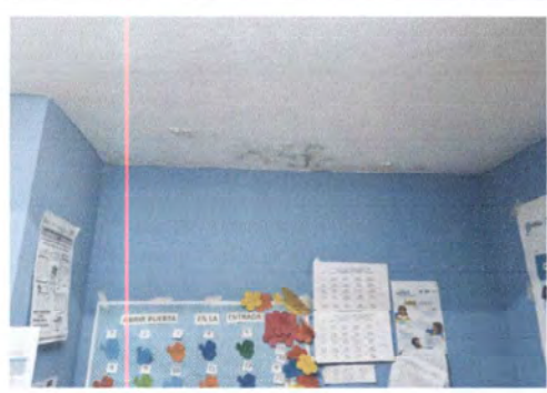
Foto 34: Reparación de filtración de agua en cenefa en el frente de las direcciones, que afecta la dirección de la jornada vespertina
