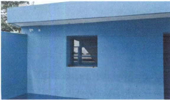
Foto 1: 5 VENTANAS: Desmontaje de ventana de la cocina, ampliación de vano de ventana, instalación de ventana corrediza de metal con medidas 1.30*0.70mts
