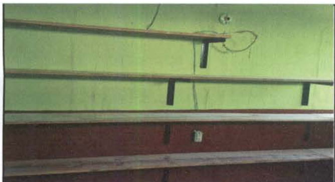
Foto 3: Estanteria terminada para biblioteca.
