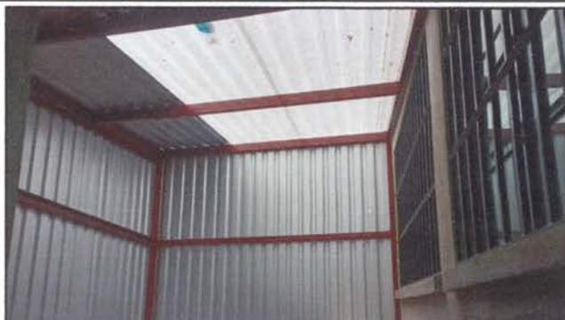
Foto 2: Sustitución de lámina, por lámina troquelada aluzinc calibre 26 y levantamiento de 2 metros para evitar caída de agua ( para 1 salon)
