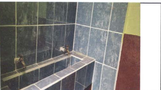
Foto 6: Sustitución de lavamanos y colocación de azulejos.
