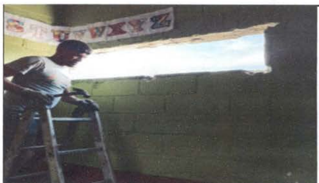
Foto 4: Desmontaje y ampliación de ventanas (10 ventanas)
