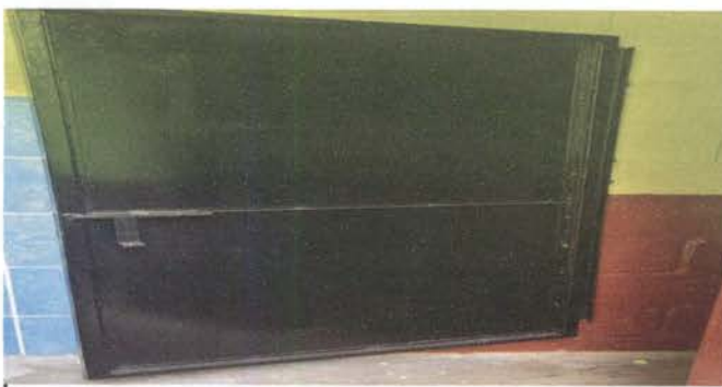
Foto 5: Mantenimiento de estructura de puertas (lijado, cepillado, aplicación de pintura. ( 3 puertas de aulas y 2 baños de niñas y niños)
