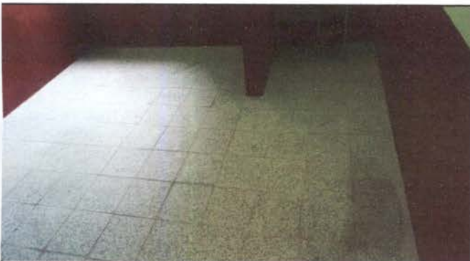
Foto 3: Piso de granito para un aula.
