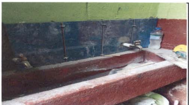
Foto 6: Sustitución de lavamanos y colocación de azulejos.
