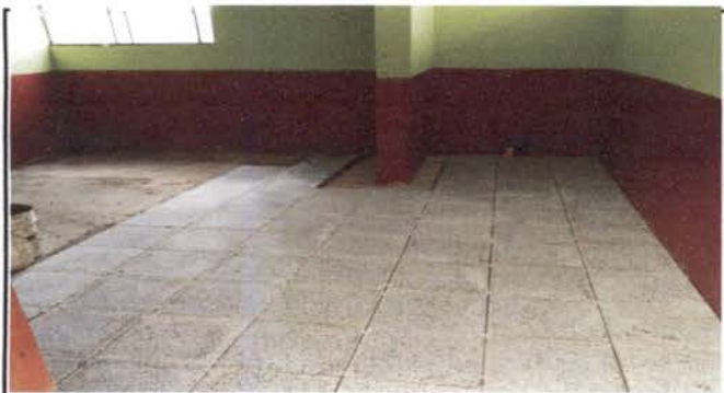
Foto 3: Piso de granito para un aula.
