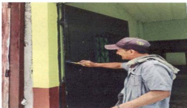
Foto 2: Mantenimiento de estructura de porton (lijado, cepillado, aplicación de pintura)
