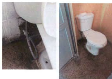
Foto 12: Reparación de fugas de sanitarios, incluye desmontaje, reparación y reinstalación, y sustitución de manguera y llave de paso
