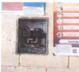
Foto 5: Instalación de acometida incluye quitar cableado actual, cablear nuevamente y colocación de nuevo tablero eléctrico y filpones
