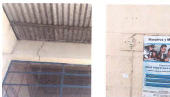
Foto 6: Reparación de un timbre y pulsador
