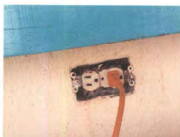
Foto 3: Desinstalación e instalación de tomacorrientes, incluye cableado y tomacorriente águila
