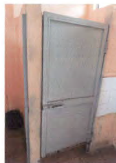
Foto 10: Reparación de puerta de baño.
