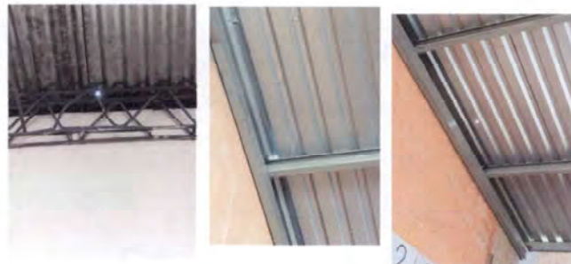
Foto 8: Reparación de goteras con silicón y/o tapagoteras en las aulas del establecimiento.
