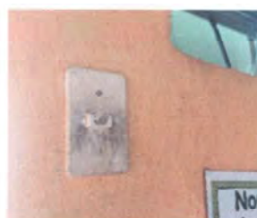
Foto 2: Desinstalación e instalación de apagadores, incluye cableado
