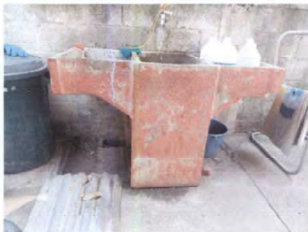
Foto 13: Cambio de pila por otra de concreto, incluye nivelar, pegar, sellar, caja, cambiar chorro y tubería hacia cisterna.
