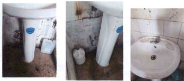
Foto 11: Reparación de lavamanos incluye, llaves, reparación de fugas, cambiar sifones, contrallaves, mangueras y limpieza
