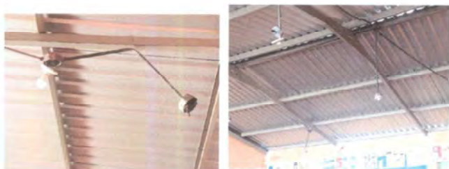
Foto 1: Desinstalación e instalación de iluminación, incluye tubería, cableado, plafonera y bombilla
