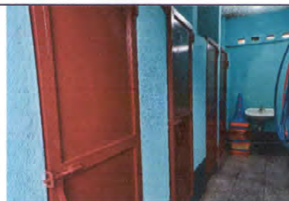
FOTO 12: MANTENIMIENTO A PUERTAS DE LOS SERVICIOS SANITARIOS DE DOCENTES
