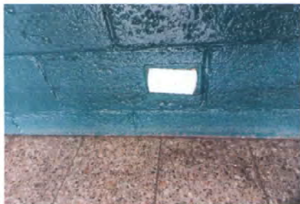
FOTO 7: INSTALACIÓN DE TOMACORRIENTE EN PASILLO DEL PRIMER NIVEL
