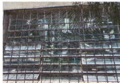
FOTO 10: SUSTITUCIÓN DE 14 VIDRIOS, INSTALACIÓN DE MALLA, E INSTALACIÓN DE BALCÓN DE METAL (HACE FALTA INSTALAR 19 M2 DE BALCÓN PARA COMPLETAR LO INDICADO EN PARA-FOR-122)
