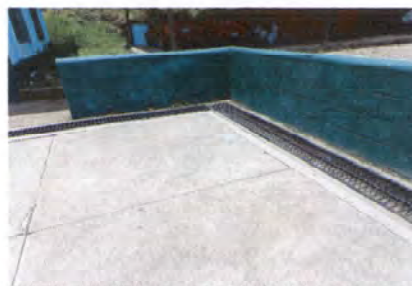
FOTO 8: REPARACIÓN DE REJILLAS EN CUNETAS
