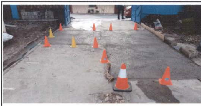
Foto 6: Reparación de placha de concreto por daño de la raíz de árbol.
