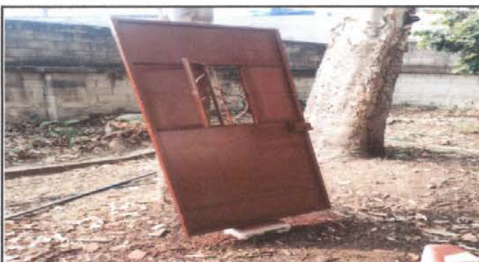
Foto 11: Mantenimiento de puertas de sanitarios .
