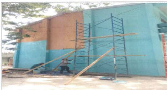
Foto 15: Pintura en áreas del primer nivel.
