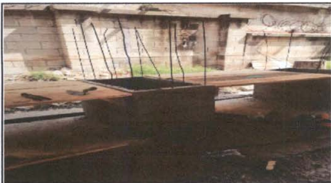
Foto 7: sustitución de pilas.
