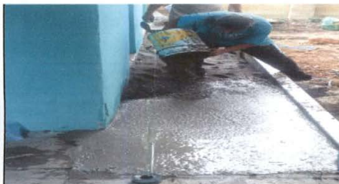
Foto 13: Reparación de banqueta de concreto
