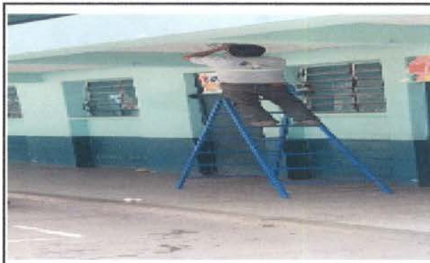
Foto 4: Sustitución de lámparas dañadas.
