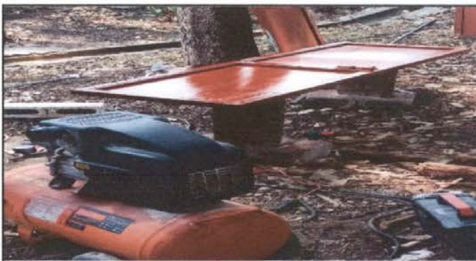
Foto 10: Mantenimiento de puertas de sanitarios .
