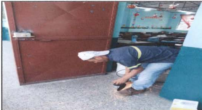
Foto 2: Instalación de 4 chapas en el 2do nivel.
