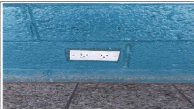
Foto 8: Sustitución de tomacorrientes dobles
