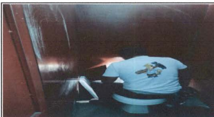
Foto 12: Sustitución de tapadera y redondel de sanitarios.
