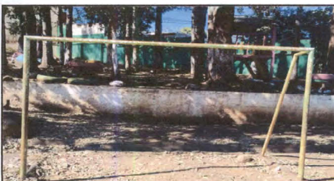
Foto 17: Pintura de porterías de futbol
