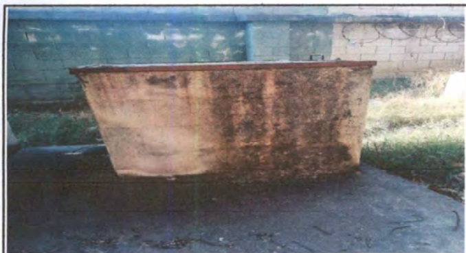
Foto 9: Reparación de sistema de concreto.
