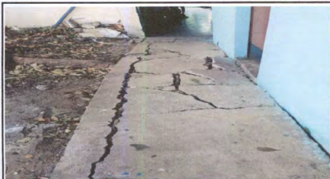
Foto 13: Reparación de banqueta de concreto
