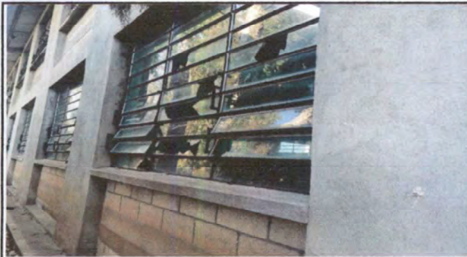
Foto1: Sustrucción de vidrios e instalación de malla galvanizada, fabricación e instalación de balcón de metal.
