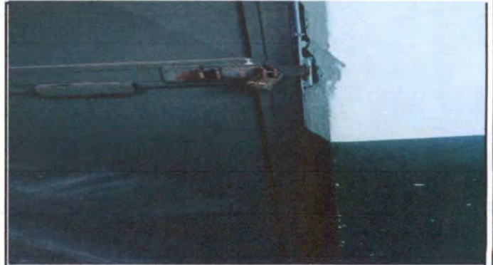
Foto 2: Instalación de 4 chapas en el 2do nivel.
