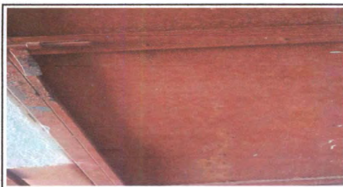
Foto 11: Mantenimiento de puertas de sanitarios.
