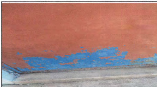
Foto 10: Mantenimiento de puertas de sanitarios.
