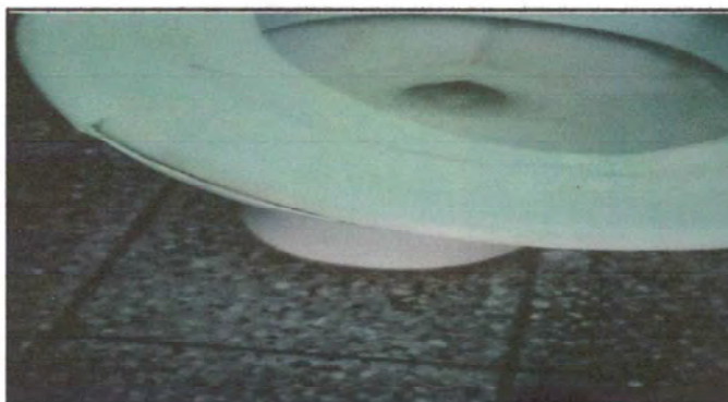
Foto 12: Sustitución de tapadera y redondel de sanitarios.
