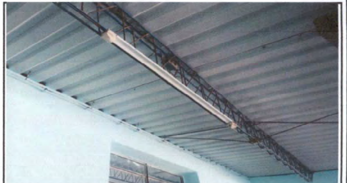
Foto 4: Sustrucción de lámparas dañadas.
