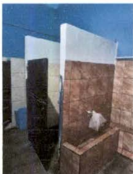
Foto 3: REPARACIÓN DE PARED EN BAÑOS DE PRIMARIA
