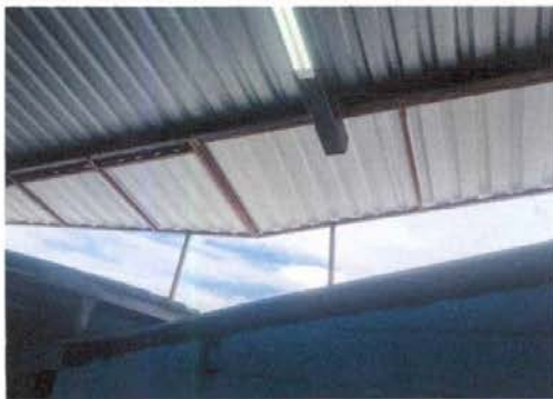
Foto 3: AMPLIACION DE TECHO
