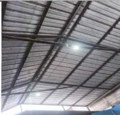
Foto1: INSTALACION DE ILUMINACIÓN EN EL PATIO PRINCIPAL
