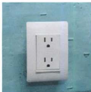
Foto 3: INSTALACIÓN DE TOMACORRIENTES
