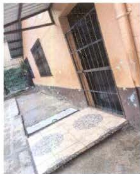
Foto 5: RAMPA EN LA ENTRADA PRINCIPAL
