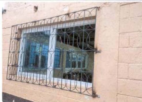
Foto 4: REPARACIÓN DE BALCONES
