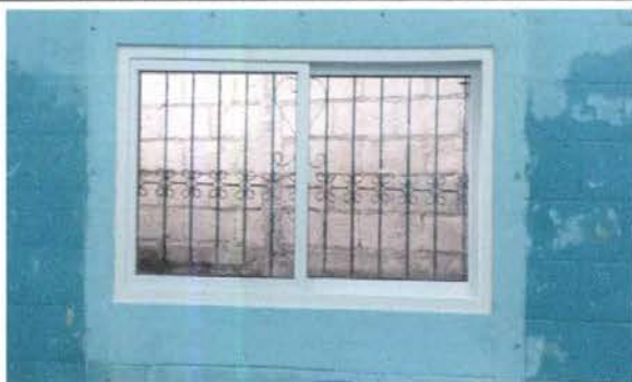
Foto 5: CAMBIO DE BALCÓN HACIA EL LADO EXTERIOR
