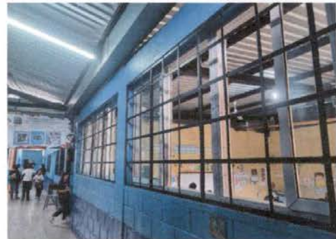
Foto 4: INSTALACIÓN DE VENTANAS DE PVC
