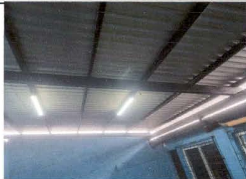
Foto 2: REPARACION DE CANDELAS DEL PATIO
