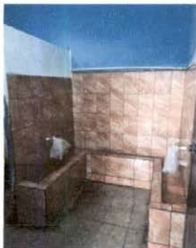
Foto 1: INSTALACION DE AZULEJO EN MINGITORIOS
