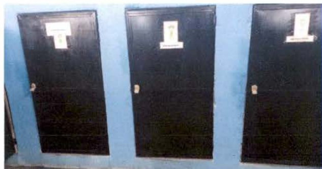
Foto 6: INSTALACION DE CHAPAS EN BAÑOS DE NIÑOS
