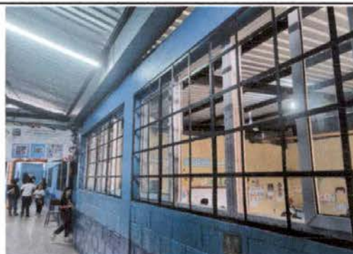
Foto 6: PINTURA DE BALCONES
