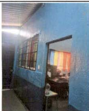
Foto 5: INSTALACIÓN DE BALCONES
