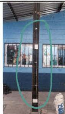
Foto 4: Sustitución de tomacorrientes
