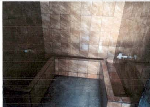
Foto 8 Sustitución de azulejo en Mingitorio
