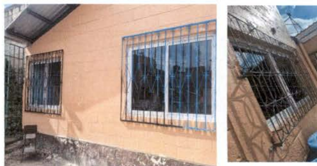
Foto 12. reparación y pintura de balcones
