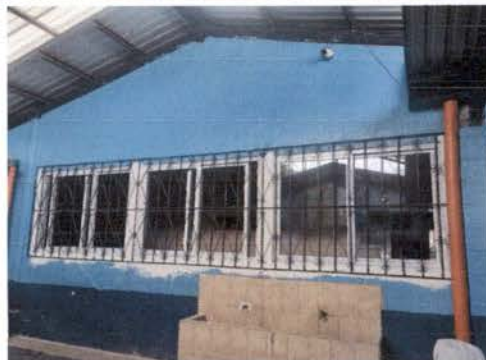
Foto 2: Sustitución de ventanería fija
