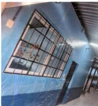
Foto 11 . Instalación de balcones
