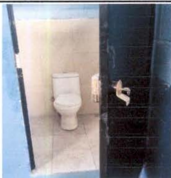
Foto 9 Incorporación de ceramica en Servicios sanitarios
