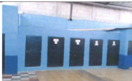
Foto 6: Incorporación de chapas para servicios sanitarios
