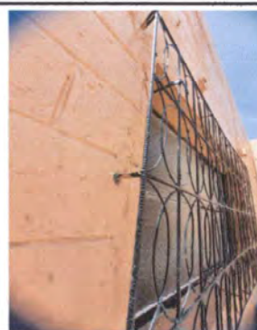
Foto 12 reparacion de balcones exteriores
