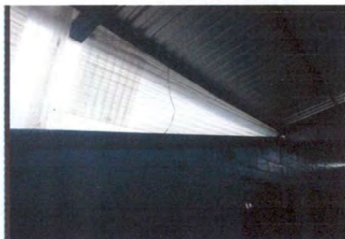
Foto 7 Instalación de estructura de metal + lámina de aluzinc
