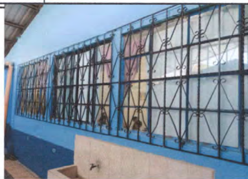
Foto 2: Sustitución de ventanería fija
