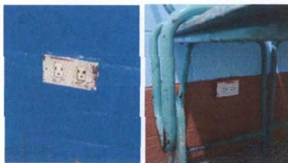
Foto 4: Sustitución de tomacorrientes
