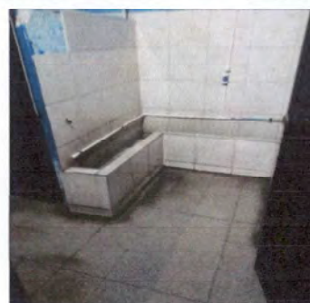
Foto 8 Sustitución de azulejo en Mingitorio
