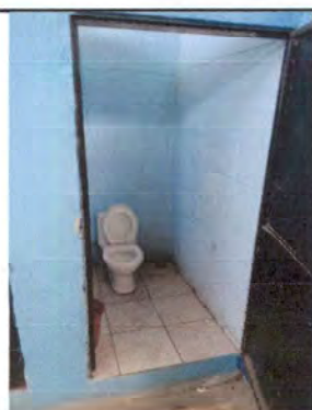
Foto 9 Incorporación de ceramica en Servicios sanitarios
