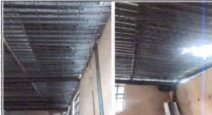
Foto 2: Cambio de estructura de techo, desmontar electromalla
