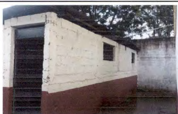
Foto 8: Pintura en muros exteriores e interiores
