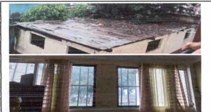
Foto 5: Sustitucion de 5 ventanas
