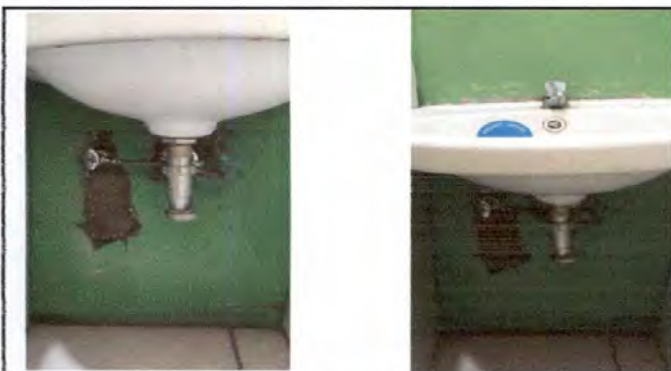
Foto 9: Reparación de fuga en lavamanos
