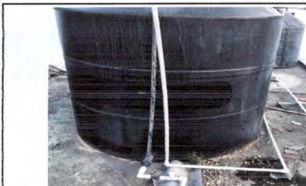
Foto 13: Reparación, cambio de accesorios de depósito de agua
