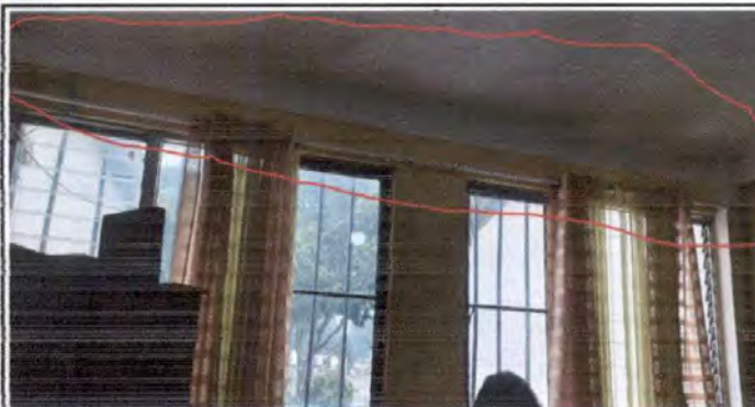
Foto 3: Impermeabilización de losa de dirección
