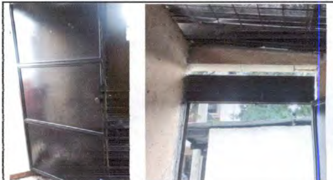
Foto 4: Remozamiento de puerta de metal
