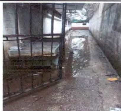
Foto 10: Instalación de 2 reposaderas en area de pilas
