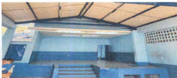
Foto1: Reparación de muros interiores
