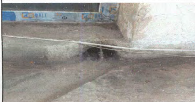
Foto 7: Reparacion bajada pasillo Sanitarios por filtracion
