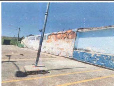
Foto 3: Pintura en muros exteriores e interiores
