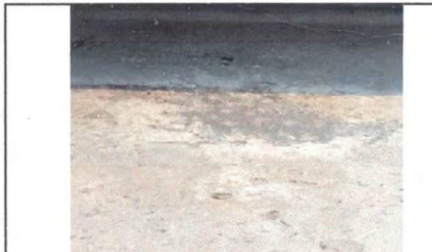
Foto 10: Impermeabilización de Losa
