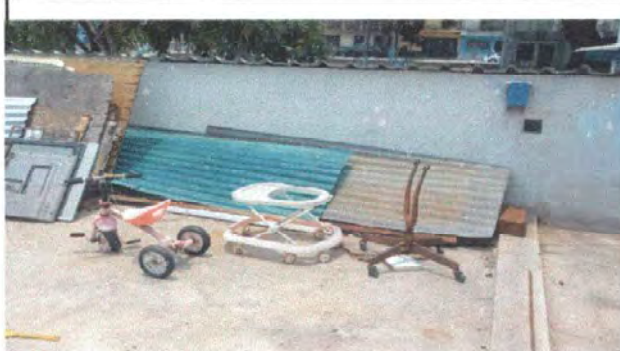
Foto 8: Impermeabilización de Losa
