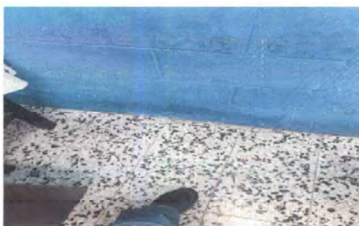
Foto 5: impermeabilización de muro
