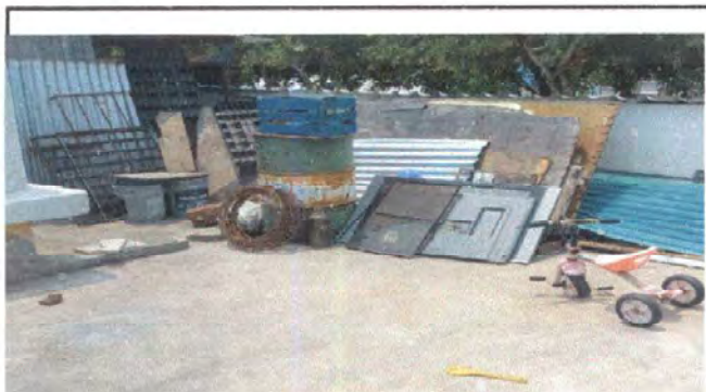
Foto 9: Impermeabilización de Losa
