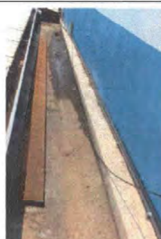
Foto 4: Reparación e impermeabilización de canal de cemento
