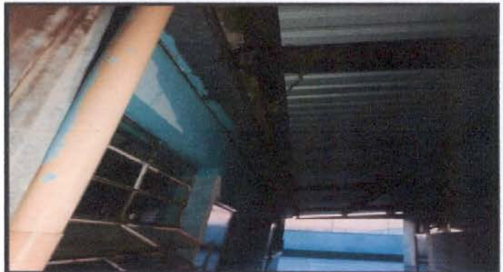
7,1 Cambio de canal y bajadas de agua,
