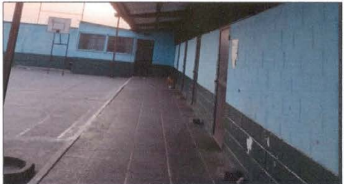
16,1 Fundicion en losa de patio.
