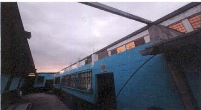
2,1 Levantado de Mojinetes 2 aulas de preprimaria,
