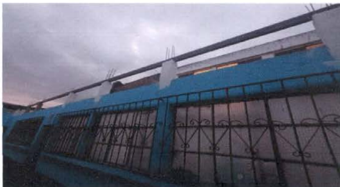
2,1 Levantado de Mojinetes 2 aulas de preprimaria,
