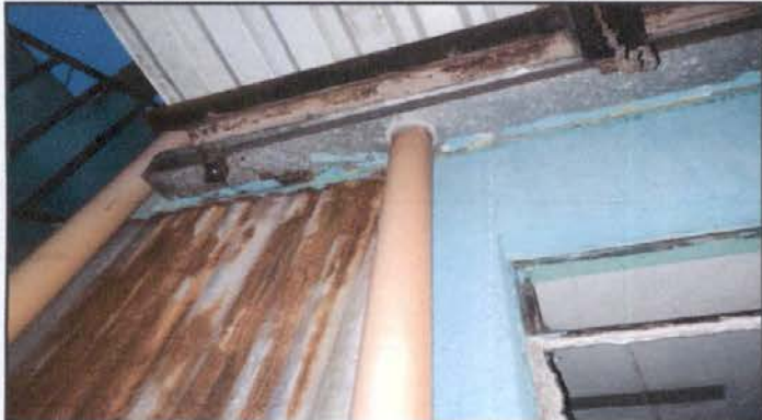
7,1 Cambio de canal y bajadas de agua,
