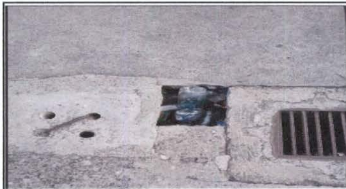
16,1 Fundicion en losa de patio.
