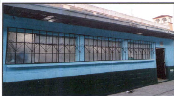
2,1 Levantado de Mojinetes 2 aulas de preprimaria,
