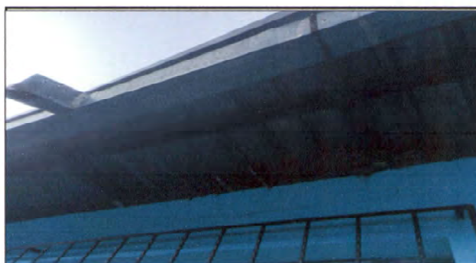
2,1 Levantado de Mojinetes 2 aulas de preprimaria,
