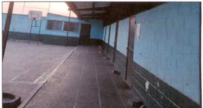
16,1 Fundicion en losa de patio.
