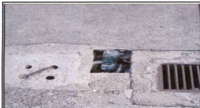
16,1 Fundicion en losa de patio.
