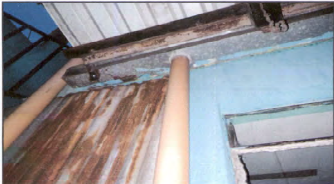
7,1 Cambio de canal y bajadas de agua,
