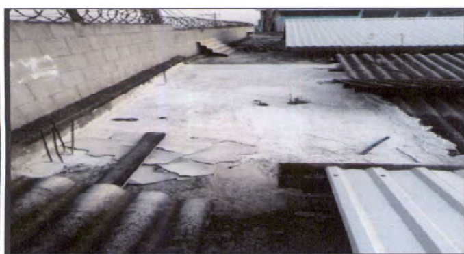
3,1 y 3,2 Aplicación de mezclon e impermeabilizacion de direccion.
