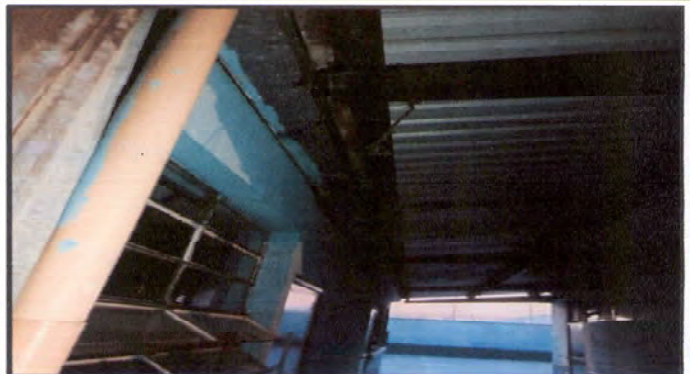
7,1 Cambio de canal y bajadas de agua,
