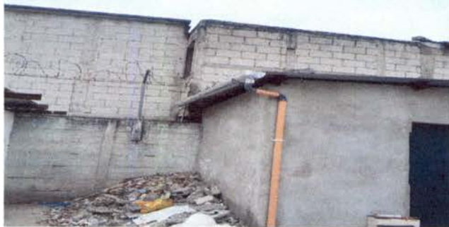
FOTO 13 : CANALES PLUVIALES Y BAJADAS DE AGUA DE BODEGA
