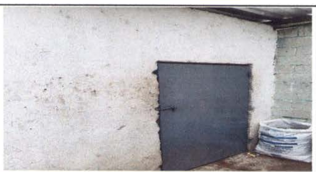
Foto 6: SUSTITUCION DE COMPUERTAS METALICAS , AREA DE BASURERO
