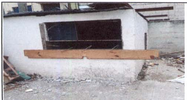
Foto 5: SUSTITUCION DE COMPUERTAS METALICAS , AREA DE BASURERO
