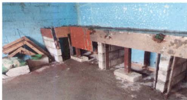
FOTO 37 : REPACION DE ENCINERA DE COCINA/PLANCHA DE CONCRETO
