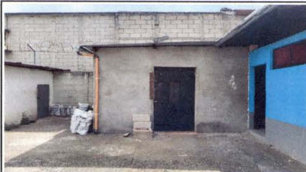
FOTO 14 :CANALES PLUVIALES Y BAJADAS DE AGUA DE BODEGA
