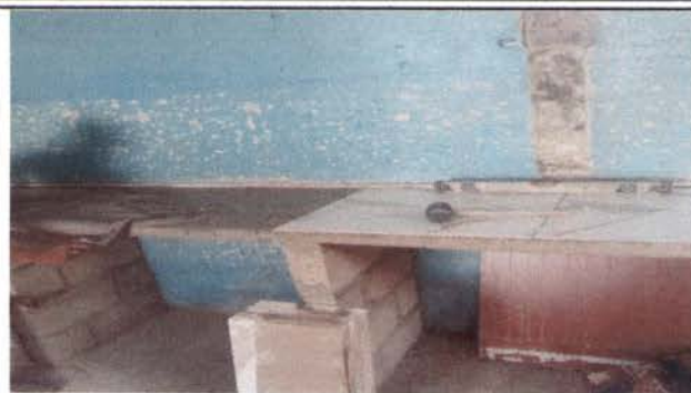
FOTO 38 :REPACION DE ENCINERA DE COCINA/PLANCHA DE CONCRETO
