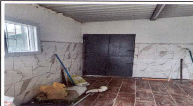
FOTO 16:REPARACION Y CERNIDO DE PAREDES DE COCINA
