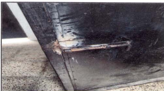
FOTO 46: MANTENIMIENTO A PUERTAS DE SANITARIOS
