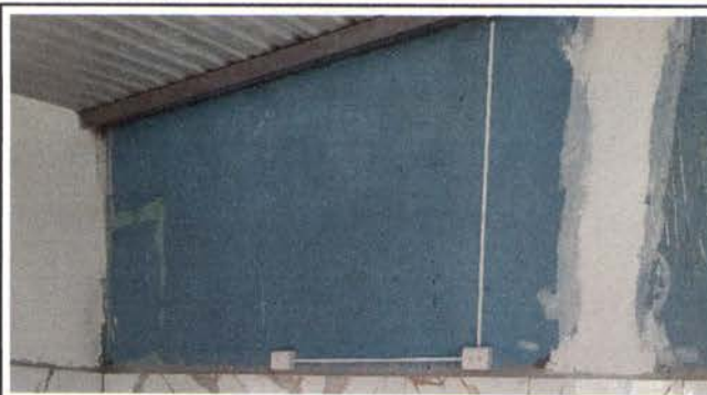
FOTO 20 : TOMACORRIENTES/APAGADORES DE COCINA
