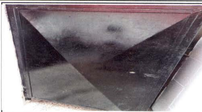
FOTO 44: MANTENIMIENTO A PUERTAS DE SANITARIOS
