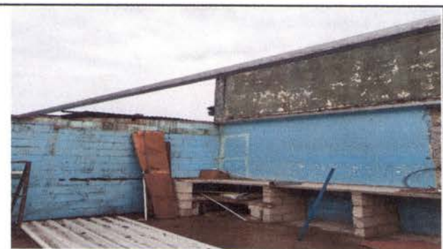
Foto 4: ESTRUCTURA DE METAL DE COCINA
