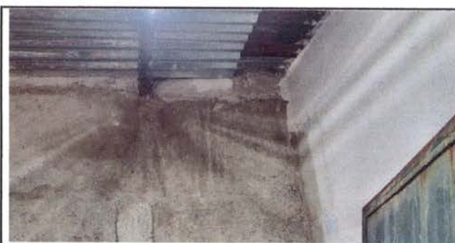
FOTO 18:REPARACION Y CERNIDO DE PAREDES DE BODEGA
