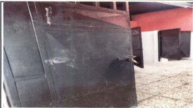
FOTO 43 : MANTENIMIENTO A PUERTAS DE SANITARIOS
