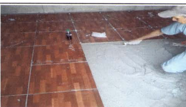
FOTO 10: COLOCACION DE PISO EN BODEGA
