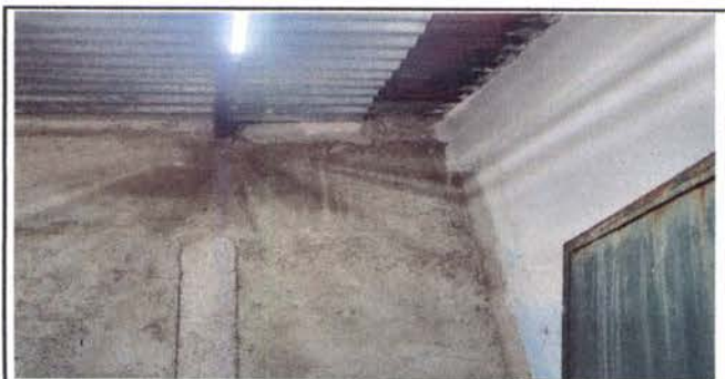
FOTO 17:REPARACION Y CERNIDO DE PAREDES DE BODEGA
