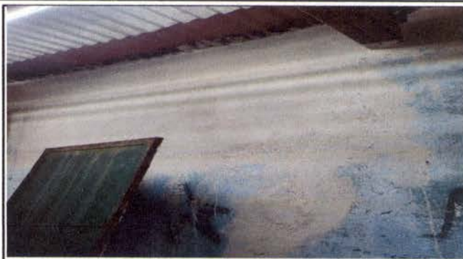
FOTO 50: REPELLO Y CERNIDO DE PARED DE BODEGA
