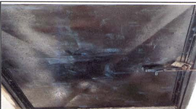
FOTO 45: MANTENIMIENTO A PUERTAS DE SANITARIOS
