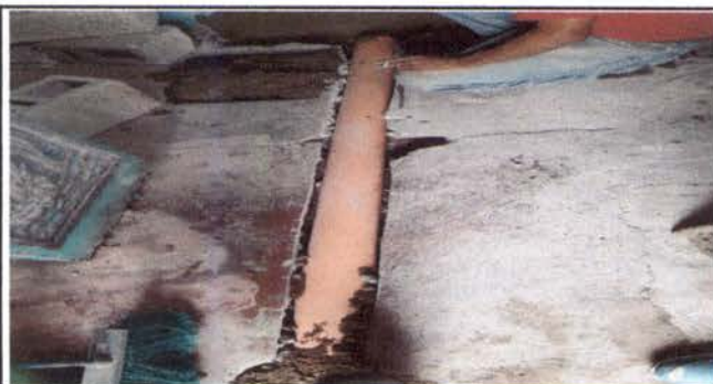
FOTO 29:SUSTITUCION Y MANTENIMIENTO DE REPOSADERAS Y DRENAJES DE COCINA Y PATIO
