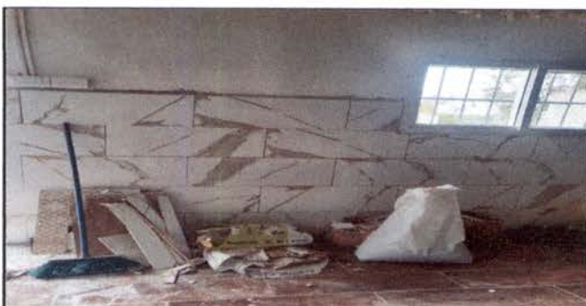
FOTO 15:REPARACION Y CERNIDO DE PAREDES DE COCINA
