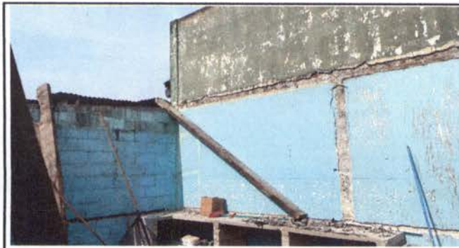
Foto 3: ESTRUCTURA DE METAL DE COCINA
