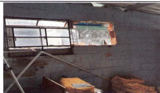
FOTO 8: SUSTITUCION Y AMPLEACION DE VENTANAS CON BALCON DE COCINA
