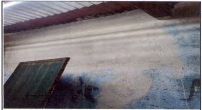
FOTO 50: REPELLO Y CERNIDO DE PARED DE BODEGA
