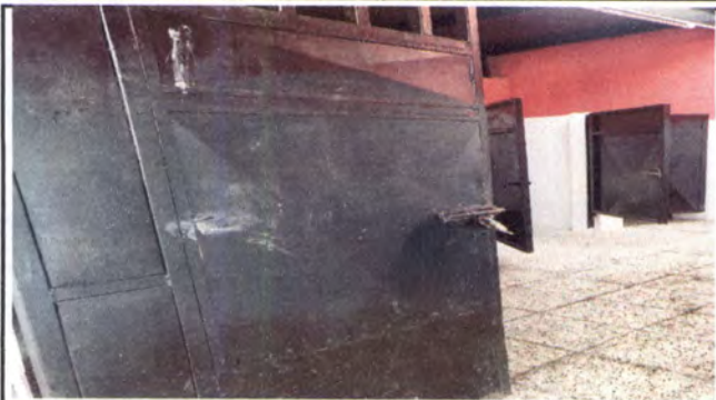
FOTO 43 : MANTENIMIENTO A PUERTAS DE SANITARIOS
