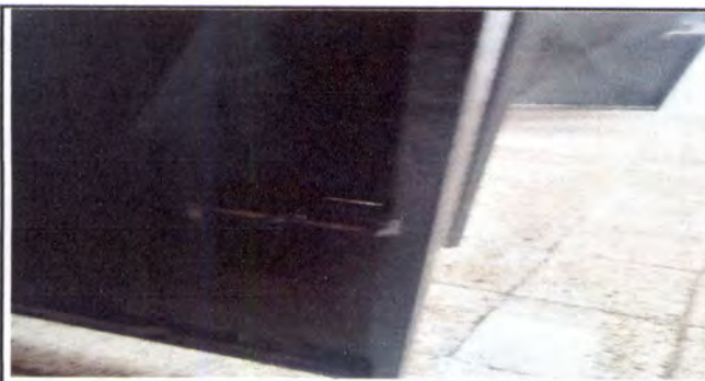
FOTO 47: MANTENIMIENTO A PUERTAS DE SANITARIOS
