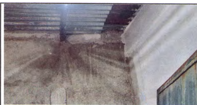
FOTO 18:REPARACION Y CERNIDO DE PAREDES DE BODEGA
