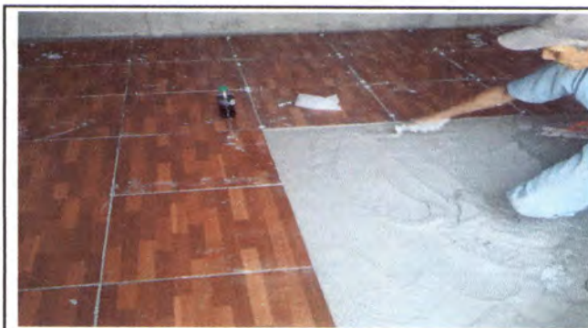
FOTO 10: COLOCACION DE PISO EN BODEGA
