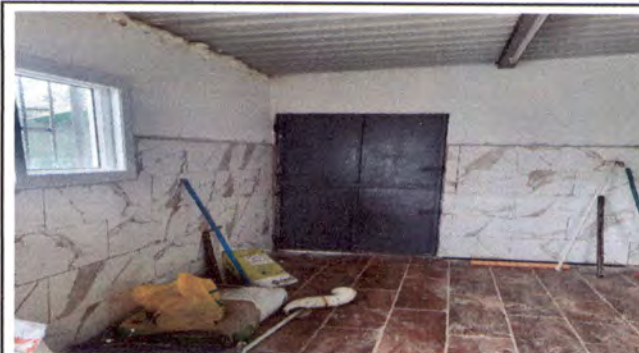
FOTO 16:REPARACION Y CERNIDO DE PAREDES DE COCINA
