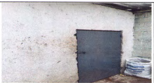
Foto 6: SUSTITUCION DE COMPUERTAS METALICAS , AREA DE BASURERO
