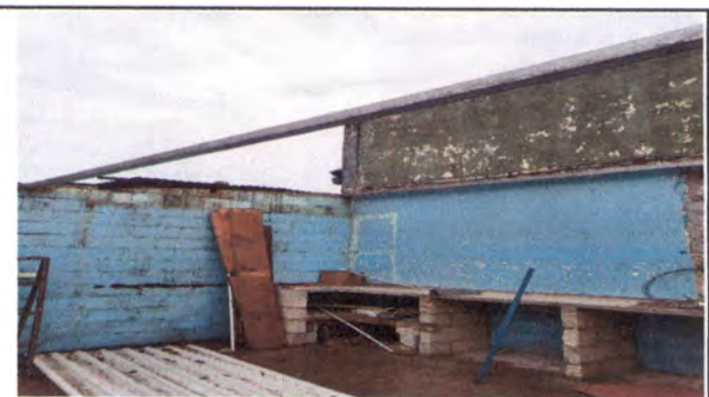
Foto 4: ESTRUCTURA DE METAL DE COCINA
