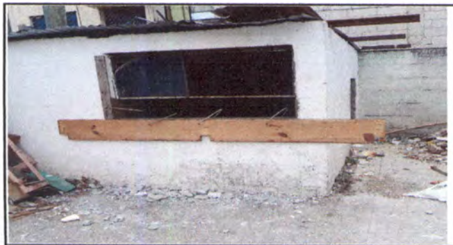
Foto 5: SUSTITUCION DE COMPUERTAS METALICAS , AREA DE BASURERO
