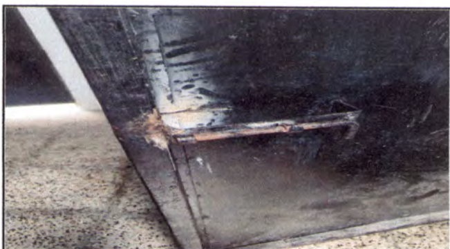
FOTO 46: MANTENIMIENTO A PUERTAS DE SANITARIOS
