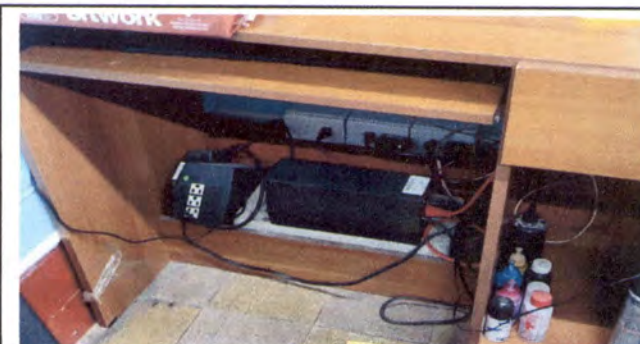
FOTO 24: TOMACORRIENTES/APAGADORES DE DIRECCION
