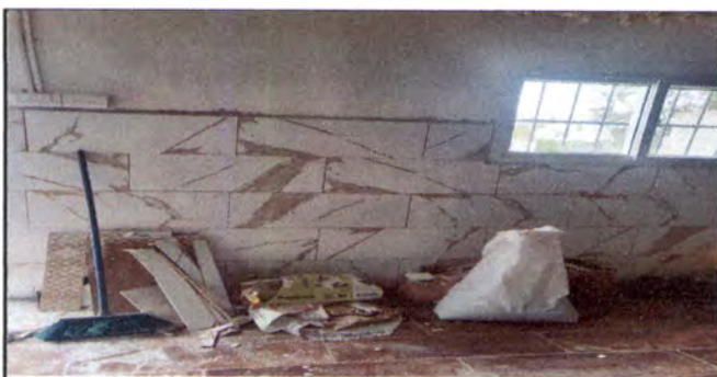
FOTO 15:REPARACION Y CERNIDO DE PAREDES DE COCINA
