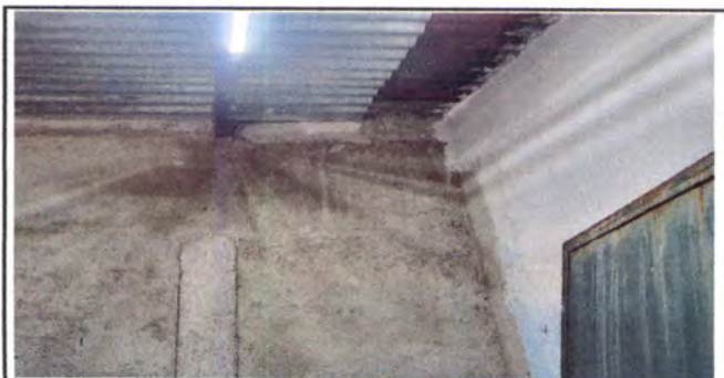
FOTO 17:REPARACION Y CERNIDO DE PAREDES DE BODEGA
