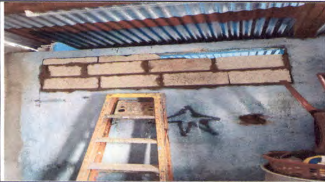
FOTO 49 : REPELLO DE CEMENTO Y CERNIDO DE PARED DE BODEGA
