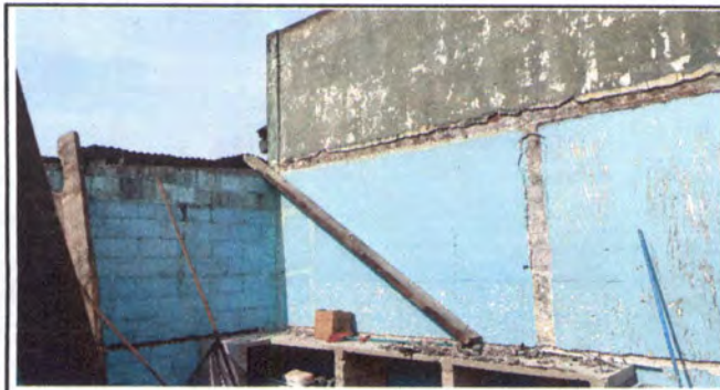
Foto 3: ESTRUCTURA DE METAL DE COCINA
