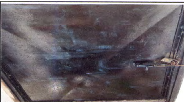
FOTO 45: MANTENIMIENTO A PUERTAS DE SANITARIOS
