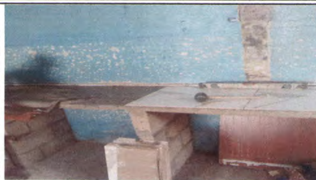
FOTO 38 :REPACION DE ENCINERA DE COCINA/PLANCHA DE CONCRETO
