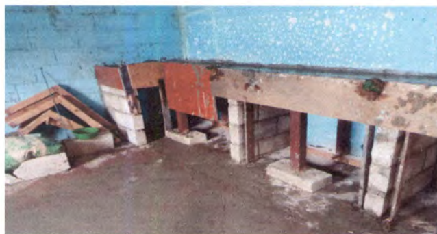
FOTO 37 : REPACION DE ENCINERA DE COCINA/PLANCHA DE CONCRETO
