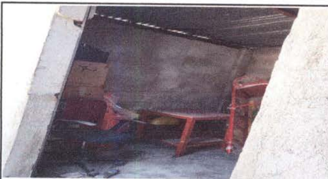
FOTO 27: PINTURA INTERIOR Y EXTERIOR, COCINA Y BODEGA
