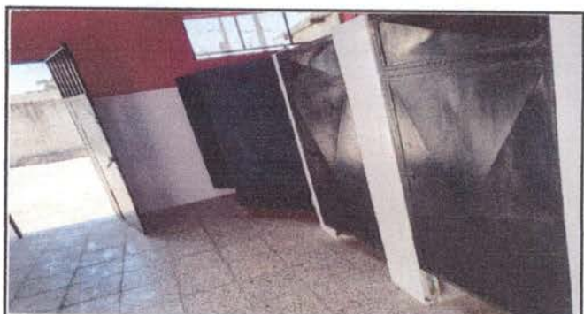
FOTO 46: MANTENIMIENTO A PUERTAS DE SANITARIOS
