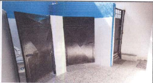
FOTO 45: MANTENIMIENTO A PUERTAS DE SANITARIOS
