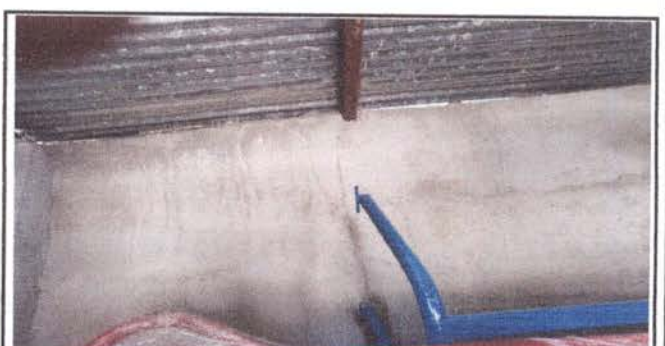
FOTO 18:REPARACION Y CERNIDO DE PAREDES DE BODEGA
