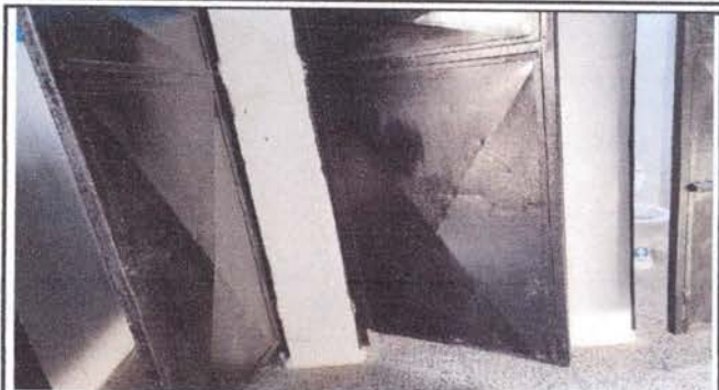
FOTO 44: MANTENIMIENTO A PUERTAS DE SANITARIOS
