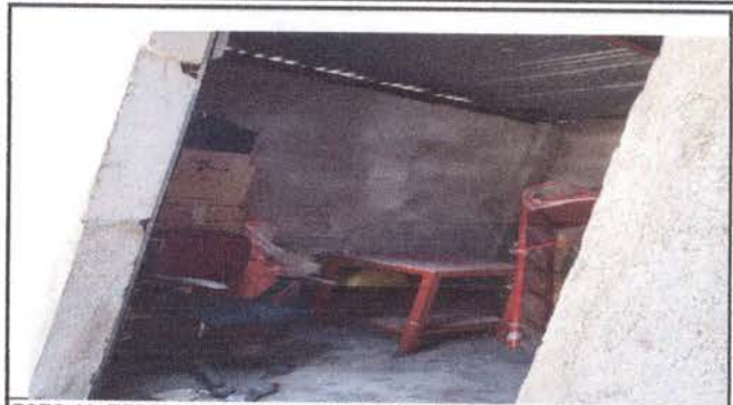
FOTO 44: REPELLO Y CERNIDO DE PARED DE BODEGA
