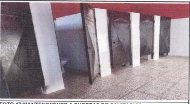
FOTO 47: MANTENIMIENTO A PUERTAS DE SANITARIOS
