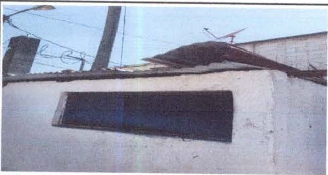
Foto 5: SUSTITUCION DE COMPUERTAS METALICAS , AREA DE BASURERO
