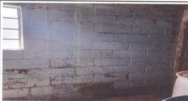
FOTO 15:REPARACION Y CERNIDO DE PAREDES DE COCINA
