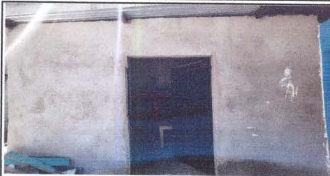
FOTO 25 : PINTURA INTERIOR Y EXTERIOR, COCINA Y BODEGA
