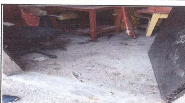
FOTO 10: COLOCACION DE PISO EN BODEGA
