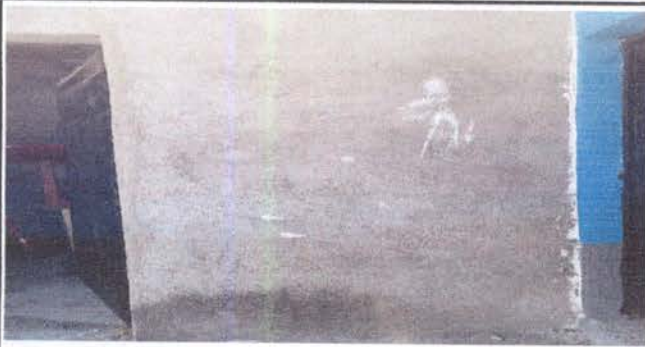
FOTO 43 : REPELLO DE CEMENTO Y CERNIDO DE PARED DE BODEGA
