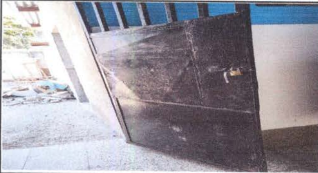
FOTO 43 : MANTENIMIENTO A PUERTAS DE SANITARIOS
