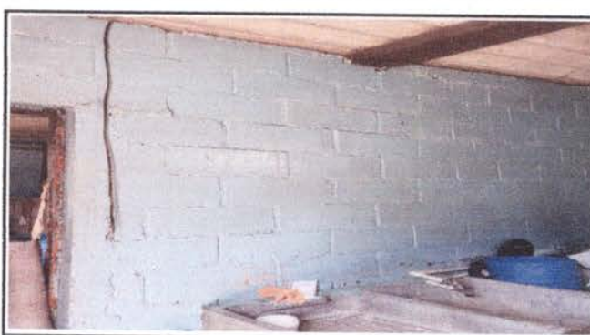
FOTO 28: PINTURA INTERIOR Y EXTERIOR, COCINA Y BODEGA
