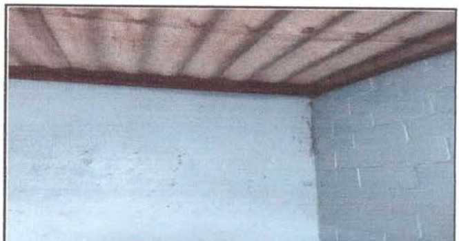
FOTO 16:REPARACION Y CERNIDO DE PAREDES DE COCINA
