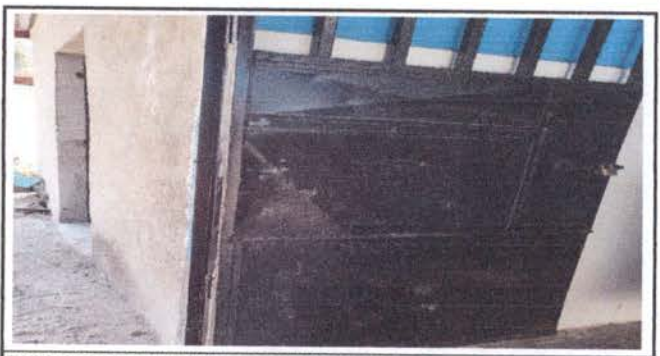
FOTO 48: MANTENIMIENTO A PUERTAS DE SANITARIOS
