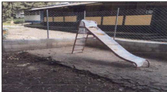
FOTO 4 COLOCACIÓN DE RESBALADERO EN ÁREA DE JUEGOS
