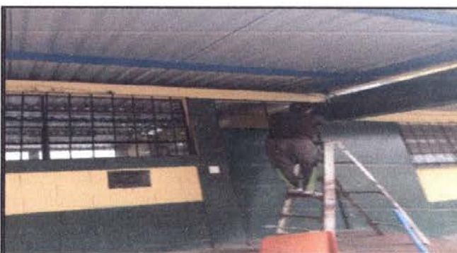
FOTO 4 COLOCACIÓN DE VIDRIOS
