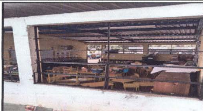
FOTO 1 SE RETIRAN VIDRIOS DE VENTANAS
