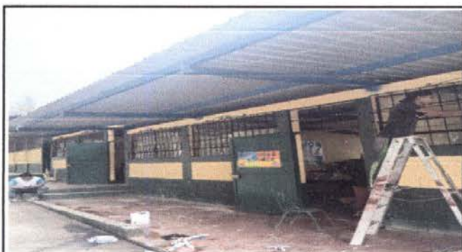
FOTO 3 COLOCACIÓN DE VIDRIOS
