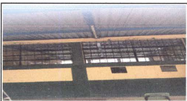
FOTO 5 COLOCACIÓN TOTAL DE VIDRIOS
