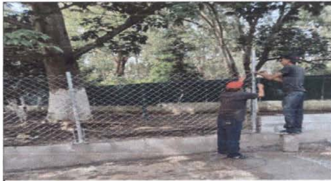
FOTO 2 COLOCACIÓN DE MAYA SOBRE EL MURO DEL ÁREA DE JUEGOS
