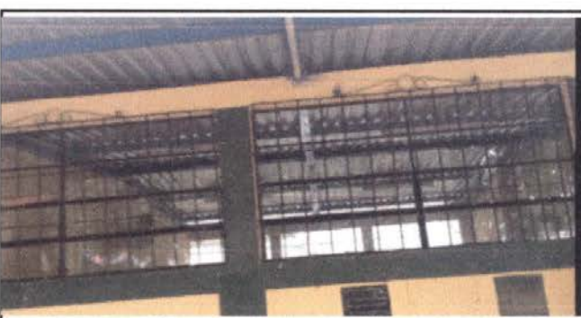
FOTO 6 COLOCACIÓN TOTAL DE VIDRIOS
