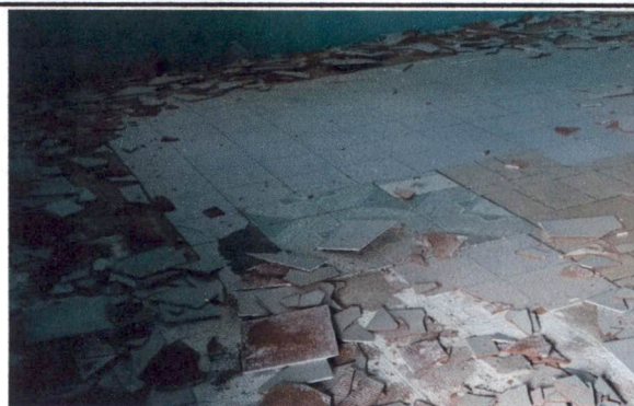
Foto 4: Momento en que retiran el piso existente en aula de 4to. A
