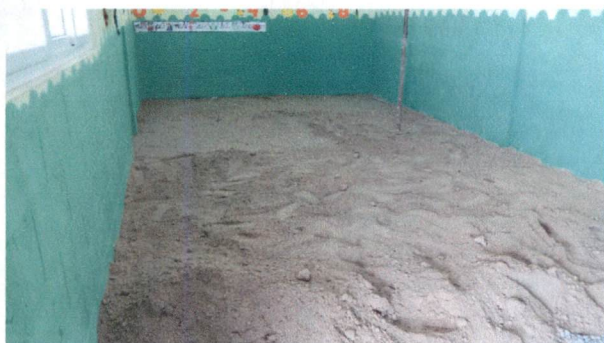
Foto 3: Relleno para nivelación, previo a colocación de piso en aula de primero B.
