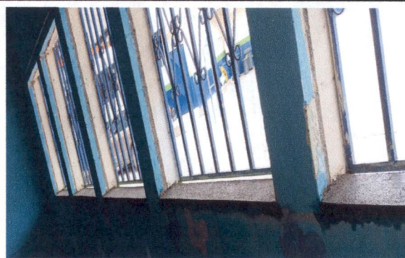
foto 2 : Tallado a marco de ventanas previo a colocación de las mismas.
