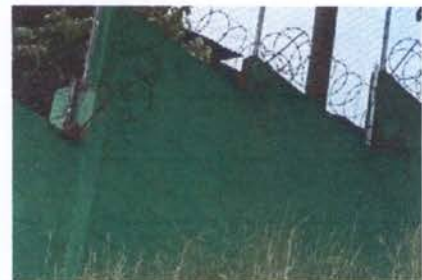
Foto 4: PINTURA EN MUROS EXTERIORES E INTERIORES
