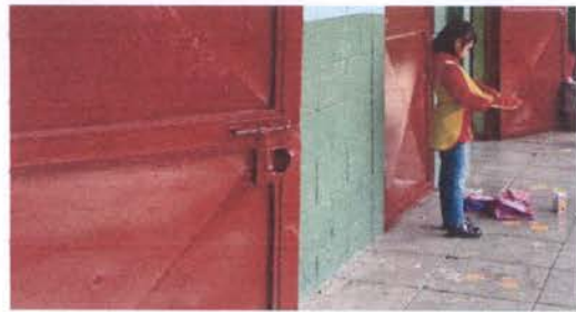
Foto 2: CAMBIO DE CHAPAS
