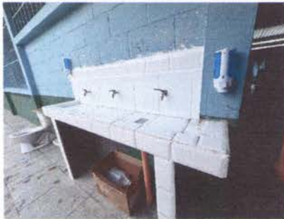
Foto 7: CONSTRUCCIÓN DE LAVAMANOS (PARA NIÑOS Y NIÑAS DE LA PRIMARIA)
