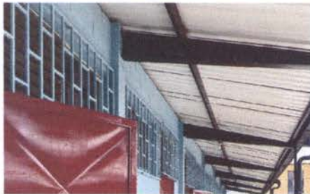
Foto 3: SUSTITUCIÓN DE VIDRIOS EN VENTANAS (PALETAS)
