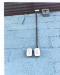
FOTO 12: REPARACIÓN DE SISTEMA ELÉCTRICO
