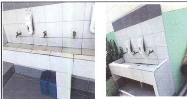
Foto17: CONSTRUCCION DE LAVAMANOS
