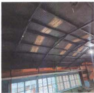
Foto 9: REPARACION DE LAMPARAS
