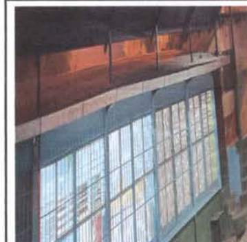
Foto 12: SUSTITUCION DE VIDRIOS
