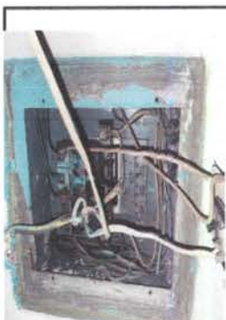
Foto 5: cambio de cajas y flippones
