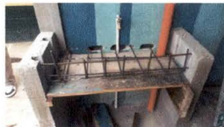
Foto 12: Suministro de piletas para lavamanos
