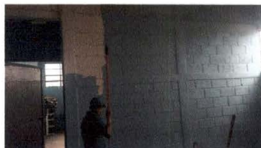
Foto 6: Pintura en muros exteriores e interiores
