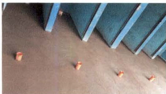
Foto 7: Reparación de piso de torta de concreto baño
