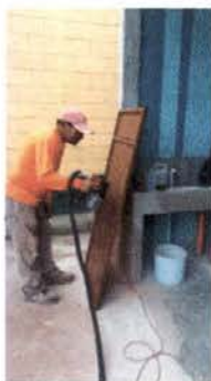
Foto 13: Mantenimiento a estructura a puerta de metal de sanitarios
