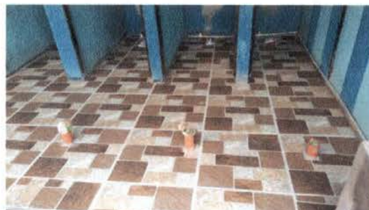
Foto 8: Reparación de piso de torta de concreto baño
