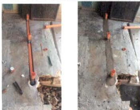
Foto 9: Suministro de reposadera y drenajes en baños
