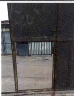
Foto 3: Mantenimiento porton de metal
