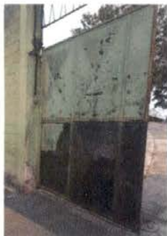
Foto 1: Mantenimiento porton de metal
