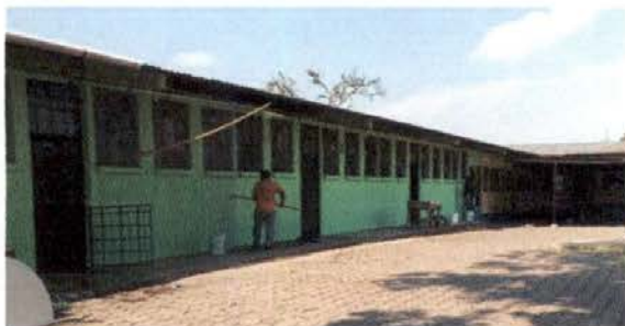
Foto 5: Pintura en muros exteriores e interiores
