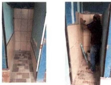
Foto 11: Suministro de azulejo en paredes de baños
