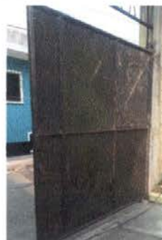
Foto 2: Mantenimiento porton de metal
