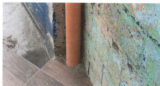
Foto 4: Se puede apreciar la bajada de agua pluvial.
