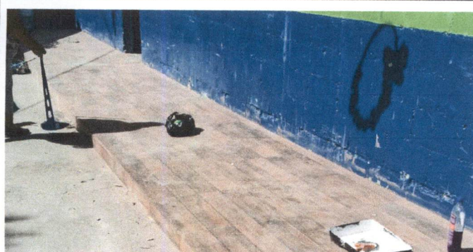
Foto 3: La sustitución de piso en corredor de preprimaria ya esta terminada. El polvo que se observa es por los otros trabajos.
