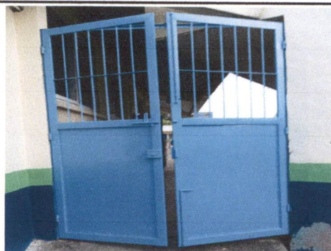
Foto 6: El mantenimiento al porton ya fue realizado.
