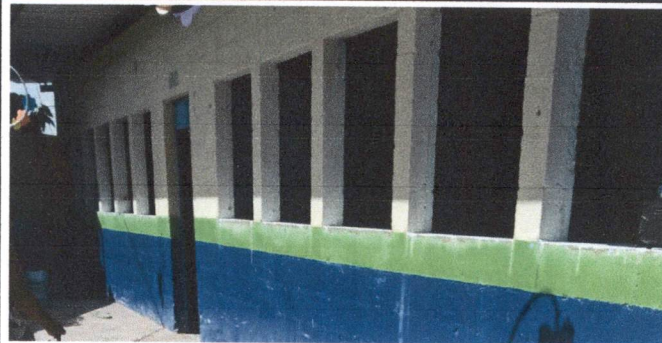
Foto 2: Las ventanas de metal fueron retiradas, proxicamente se colocaran las nuevas de PVC.
