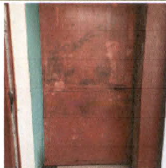
mantenimiento a puertas dañadas
