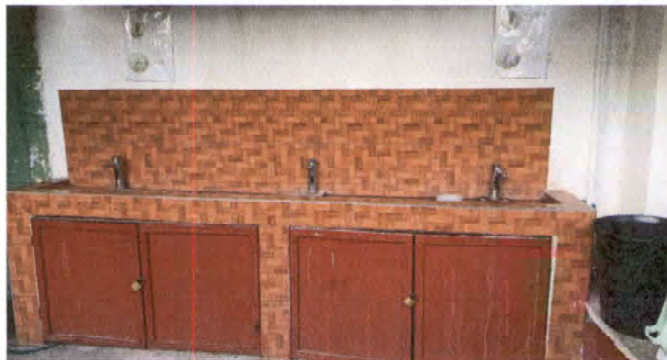
sustitucion de grifos de lavamanos
