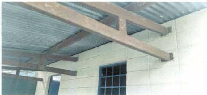
Foto 3: Sustrucción de lámina y levantamiento de dos hiladas por exceso de calor.
