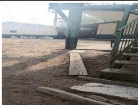
Foto 11: Fabricación de losa de patio
