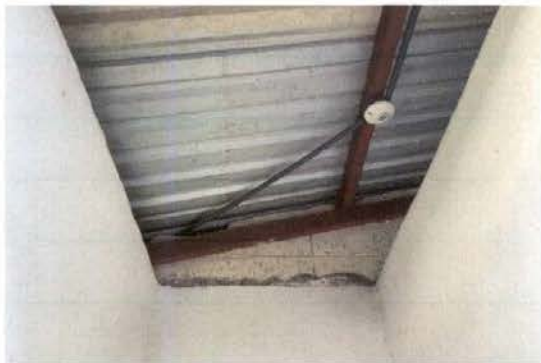
Foto 13: Reparación de sistema eléctrico y luz LED
