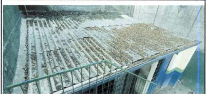
Foto2: Sustrucción de lámina en bodega
