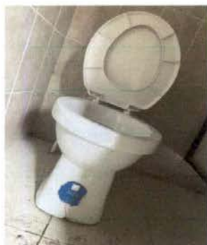
Foto 9: Reparación de accesorios en sanitarios
