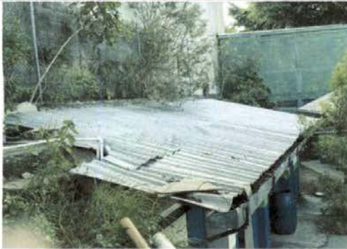
Foto1: Sustrucción de lámina en sanitario de docentes, alumnos y alumnas.
