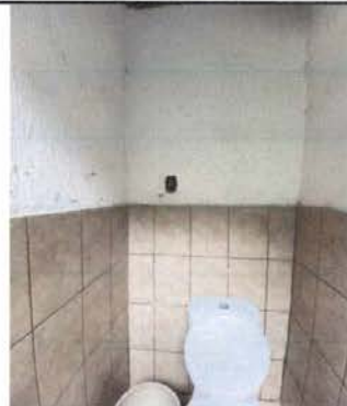
Foto 14: Reparación de interruptores en sanitarios
