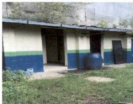
Foto 12: Fabricación de losa de patio en sanitarios
