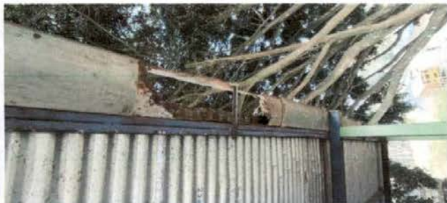
Foto 7: Sustitución de canales y bajas de agua
