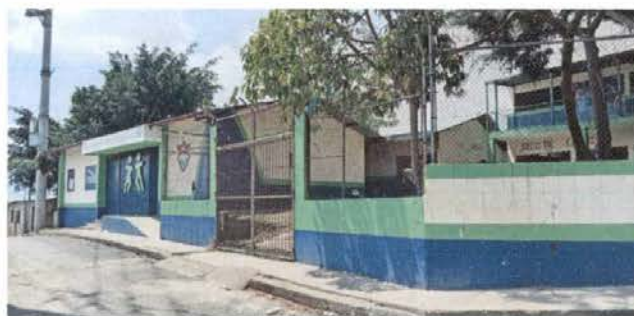
Foto 10: Sustitución de alambre de pua razor
