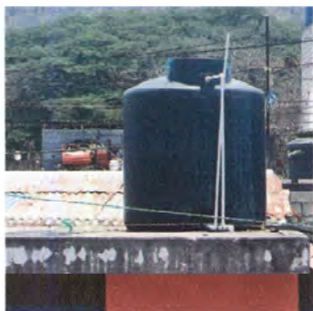
Foto 7: Sustitución de deposito de agua 1700 lt.
