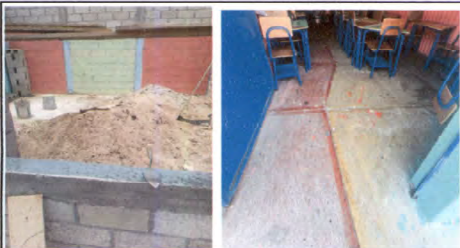
Foto 3: sustitución de piso de torta de concreto por piso de granito en el área de cocina, clase de párvulos 3 "C" y bodega.
