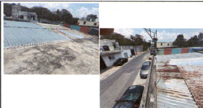
Foto 4: Sustrucción de canales de metal, reparación de baja de agua pluvial y sustitución de soporte de metal para canal.
