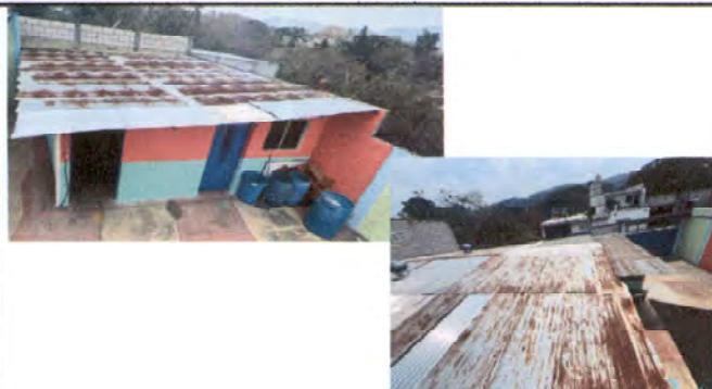
Foto1: Sustrucción de lámina en las áreas de cocina, clases de párvulos 2 "A", párvulos 3 "A", párvulos 3 "B" párvulos 3 "C" y bodega.
