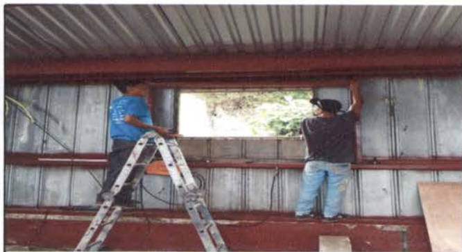
Foto 3: Desmantelar aula de madera y metal.
