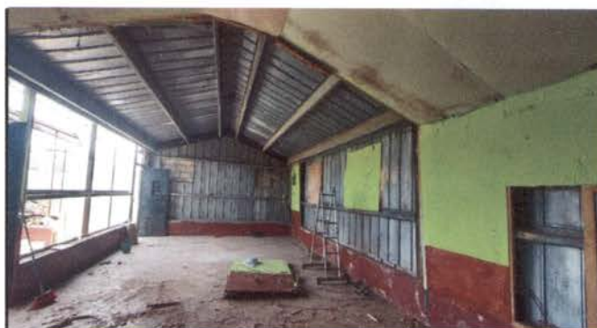
Foto 4: Desmantelar aulas de madera y metal.
