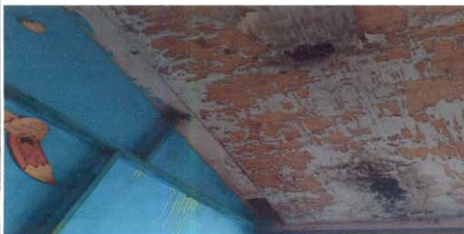
Foto 7: Sustrucción de estructura de soporte de madera por metal, desmontaje de madera por metal e instalación de costaneras.
