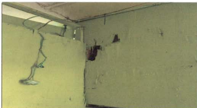
Foto 10: Sustrucción de tomacorrientes dobles.
