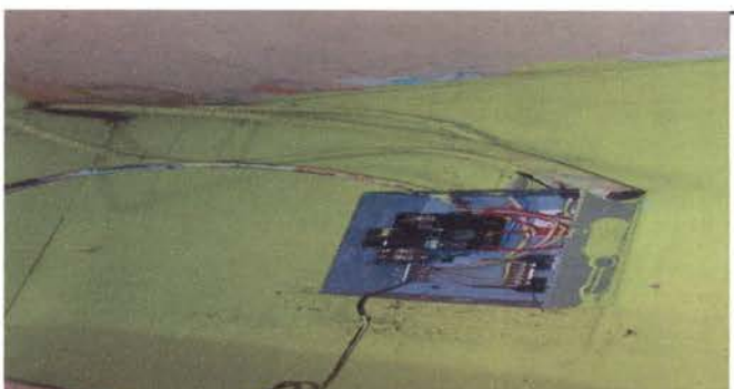
Foto 12: Sustrucción de ducto eléctrico mas accesorios
