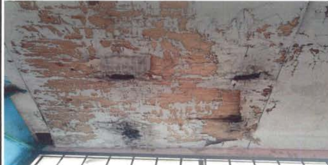
Foto 8: Sustrucción de estructura de soporte de madera por metal, desmontaje de madera por metal e instalación de costaneras.
