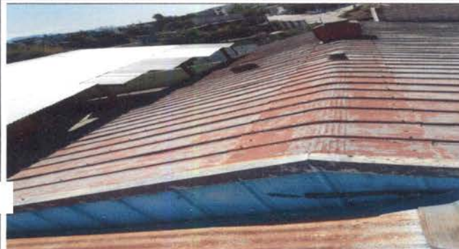
Foto 1: Sustrucción de lámina, por lamina troquelada aluzinc calibre 26 (3 salones), desmontaje de lámina antigua e instalación de lámina nueva.
