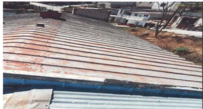
Foto 2: Sustrucción de lámina, por lamina troquelada aluzinc calibre 26 (3 salones), desmontaje de lámina antigua e instalación de lámina nueva.
