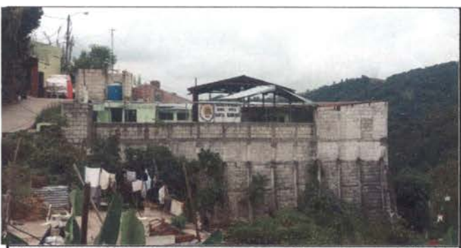
Foto 6: Impermeabilización de muro de contención con impermeabilizante
