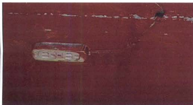
Foto 9: Sustrucción de tomacorrientes dobles.
