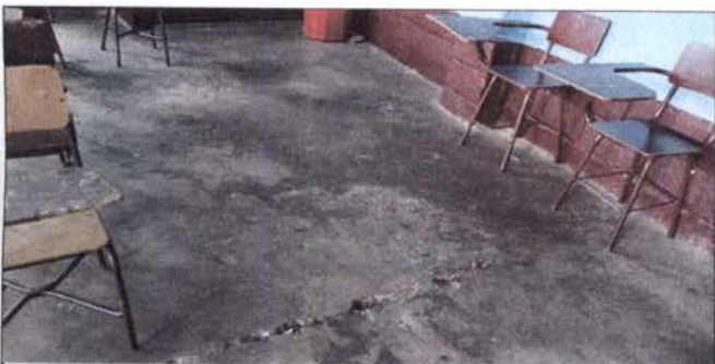
PISO: Sustitución de piso de torta de concreto por ceramico en tres salones de tercer grado, ubicados en el primer nivel.
