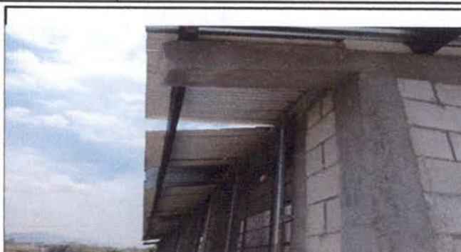
CUBIERTA DE LAMINA: Sustitución de lámina plastica por lámina troquelada aluzinc calibre 26, en tres salones de segundo grado ubicados en el segundo nivel.
