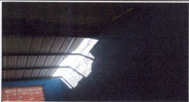
CUBIERTA DE LAMINA: Sustitución de lámina plastica por lámina troquelada aluzinc calibre 26, en salones de segundo grado, ubicados en el segundo nivel.
