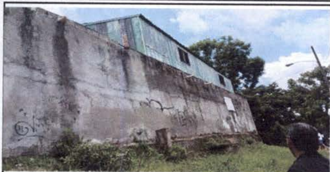
CANALES Y BAJADAS DE AGUA PLUVIAL: Reparación de bajadas de agua pluvial tubo pvc.
