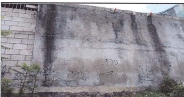
IMPERMEABILIZACION DE LOZA: Reparación de pañuelos a tres salones de sexto grado.
