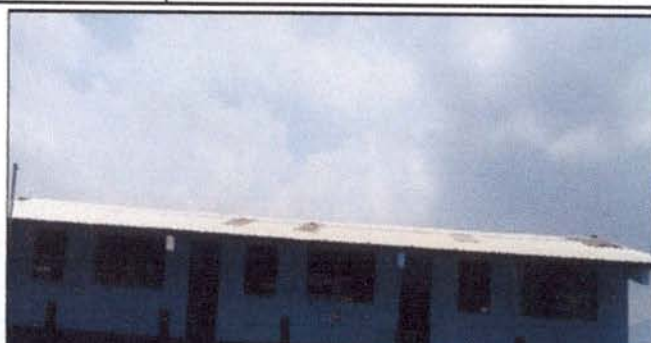
CANALES Y BAJADAS DE AGUA PLUVIAL: Sustitución por canal de pvc.
