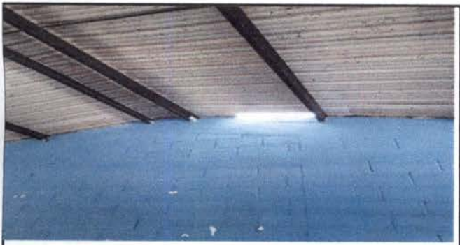
ESTRUCTURA DE TECHO: Mantenimiento a estructura de soporte de metal en tres salones de segundo grado ubicados en el segundo nivel.
