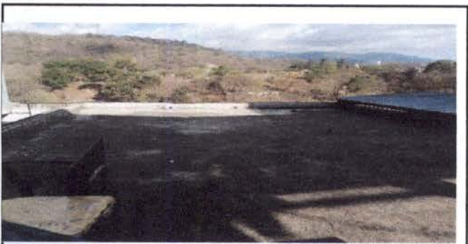
IMPERMEABILIZACION DE LOZA: Impermeabilización de loza a salones de sexto.
