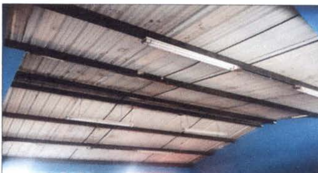
ESTRUCTURA DE TECHO: Mantenimiento a estructura de soporte de metal en tres salones de segundo grado, ubicados en el segundo nivel.
