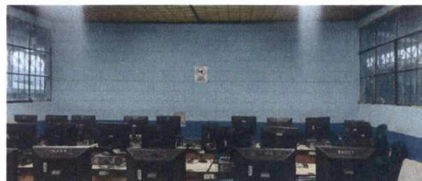
Foto 8: Sustitución de tomacorrientes dobles
