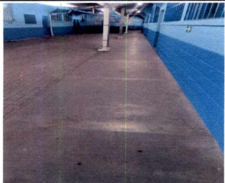
Foto 3: Sustrucción de piso de granito en pasillo
