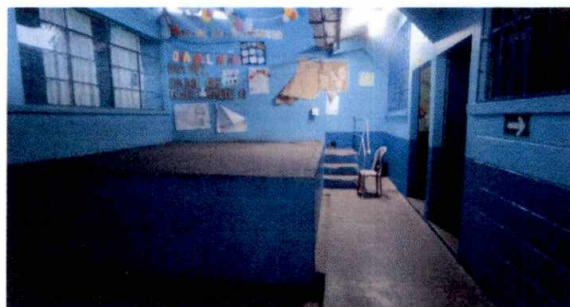
Foto 4: Sustrucción de piso de granito en escenario y gradas
