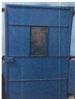
Foto 9: Sustitución de chapa yale en puerta de dirección
