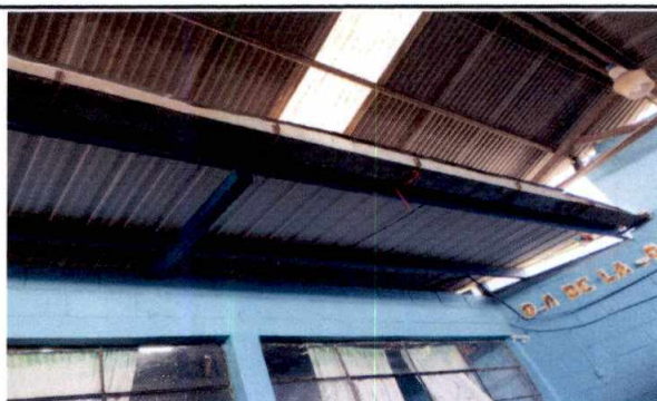
Foto 5: canal y bajada de agua pluvial
