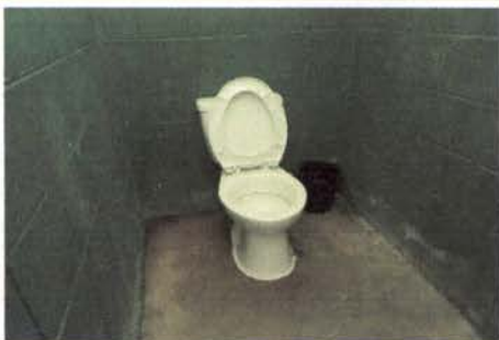
FOTO 3: SUSTITUCIÓN DE INODORO
