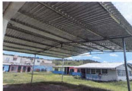
FOTO 2: SUSTITUCIÓN DE LÁMINA POR LÁMINA TROQUELADA ALUZINC CALIBRE 26 EN GALERA DE PATIO
