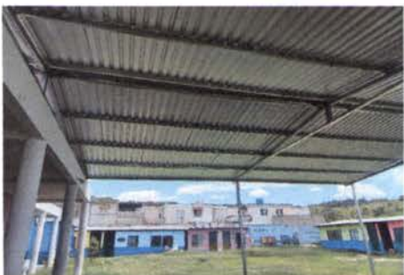
FOTO 1: SUSTITUCIÓN DE LÁMINA POR LÁMINA TROQUELADA ALUZINC CALIBRE 26 EN GALERA DE PATIO
