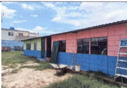
FOTO 6: DESINSTALACIÓN DE CANAL Y PUERTAS PARA EL PROCESO DE SUSTITUCIÓN DE CANAL Y CHAPAS.
