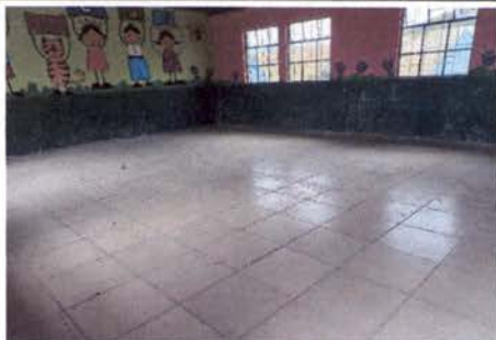
FOTO 4: SUSTITUCIÓN DE PISO DE TORTA DE CONCRETO POR PISO ANTIDESLIZANTE EN 6 AULAS.
