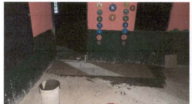
Foto 4: SE EMPIEZA A COLOCAR EL NUEVO PISO
