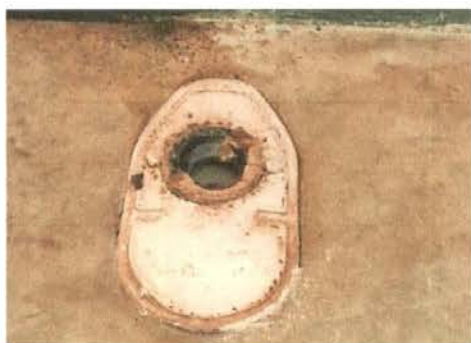
Foto 5: SUSTITUCIÓN DE BAÑOS
