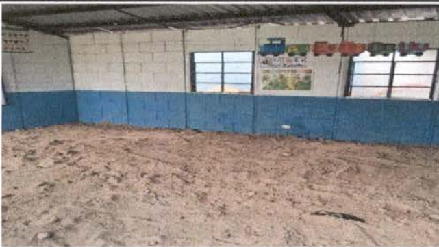
Foto 3: MEZCLA DE CEMENTO CAL Y SELECTO
