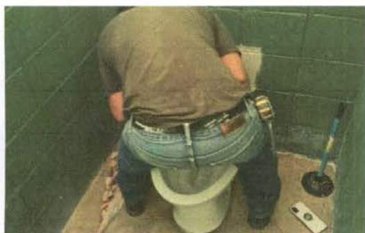
Foto1: SUSTITUCIÓN DE BAÑOS
