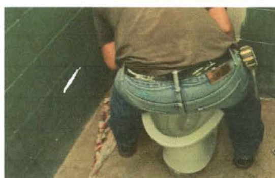
Foto 2: SUSTITUCIÓN DE BAÑOS
