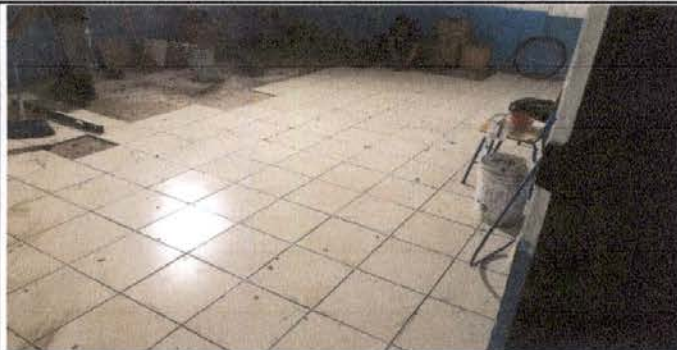
Foto 5: SEGUIMIENTO DEL PISO EN LAS AULAS
