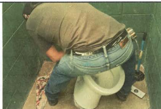
Foto 3: SUSTITUCIÓN DE BAÑOS
