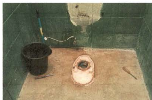
Foto 4: REMOVIERON POR COMPLETO EL SANITARIO
