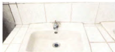
Foto 2: Sustitucion de accesorios e inodoros y lavamanos.
