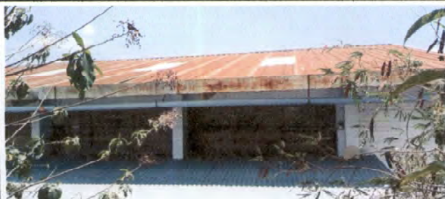
Foto 1: Sustitucion de lamina por lamina troquelada aluzyzinc calibre 26
